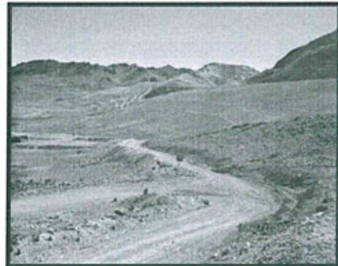
Foto N° 18: Acceso a los componentes falta completar el cierre
