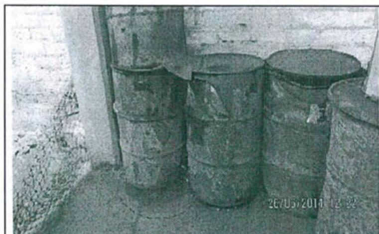
Foto N° 10. Los cilindros (residuos peligrosos) presentan oxidación así como signos de filtración sobre el piso de cemento que carecen de medios de contención y se ubica cerca al suelo afirmado.
