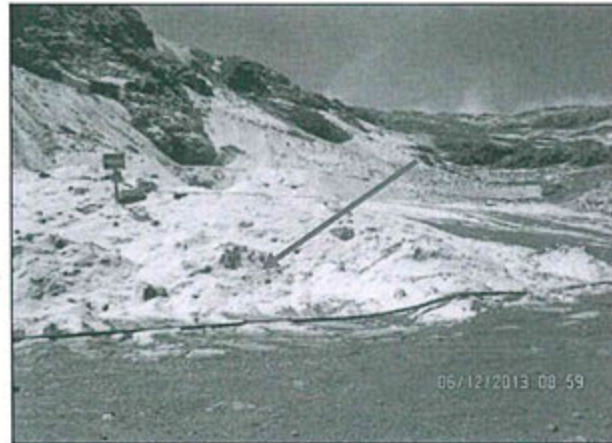
Fotografía N° 110: Depósito de desmontes o de material de préstamo frente al almacén de "top soil" en Suyckutambo, que no está autorizado.
