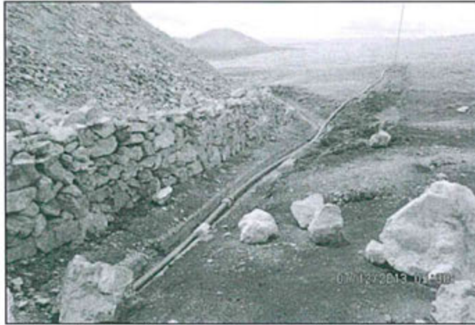
Fotografía N° 99: Canal de coronación del depósito de desmontes contemplado en el EIA Suyckutambo.
