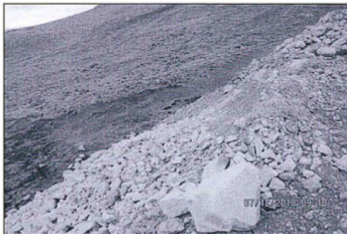
Fotografía N° 93: Depósito de desmontes no contemplado en el EIA de la U. M. El Diablo sin canal de coronación.
