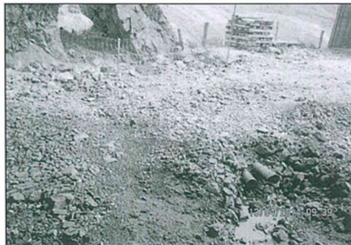
Fotografía N° 141.- Descarga de efluente bocamina del nivel 40 veta Santa Úrsula en la U. M. Suyckutambo, hacia el nivel inferior.
