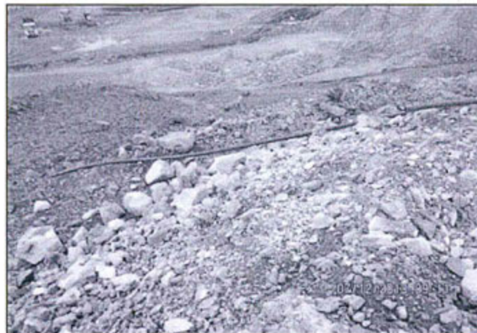
Fotografía N° 88: Depósito de desmontes no contemplado en el EIA de la U. M. El Diablo sin canal de coronación.
