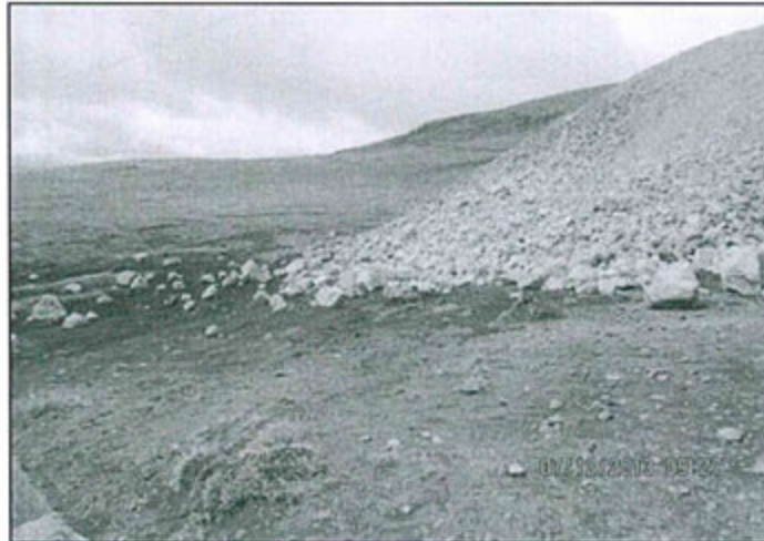
Fotografía N° 95: Depósito de desmontes no contemplado en el EIA, sobre suelo orgánico.
