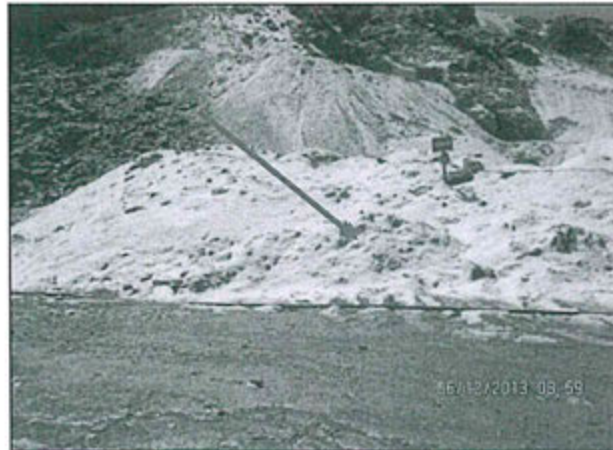
Fotografía N° 109: Depósito de desmontes o de material de préstamo frente al almacén de "top soil" en Suyckutambo, que no está autorizado.
