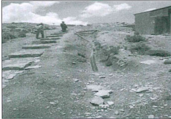
Fotografía N° 73: Tubería de conducción de relaves.
