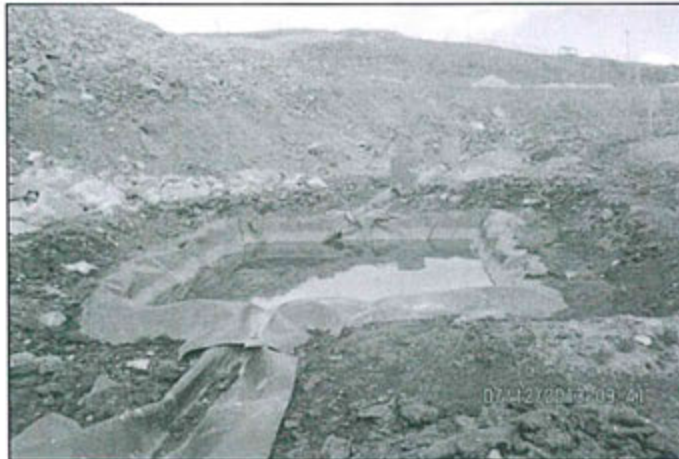
Fotografía N° 106: poza de tratamiento y sedimentación de drenajes del depósito de desmontes.
