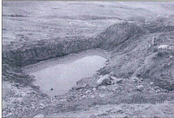
Fotografía N° 102: Poza de desmote al pie del canal de coronación y derivación de aguas de escorrentía del depósito de desmontes.
