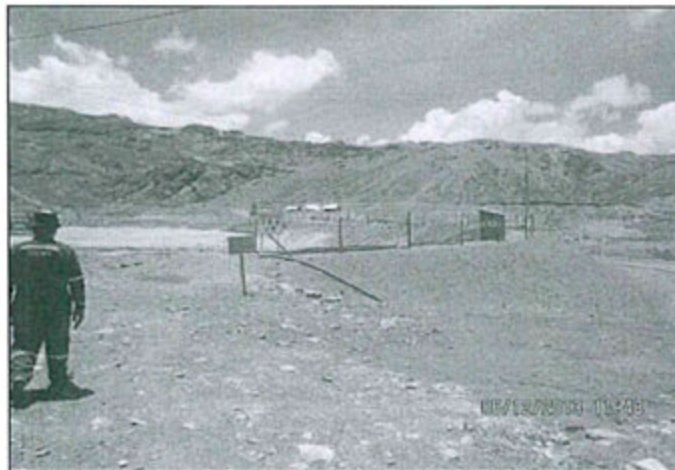
Fotografía N° 75: Tubería de conducción de relaves y depósito de relaves.
