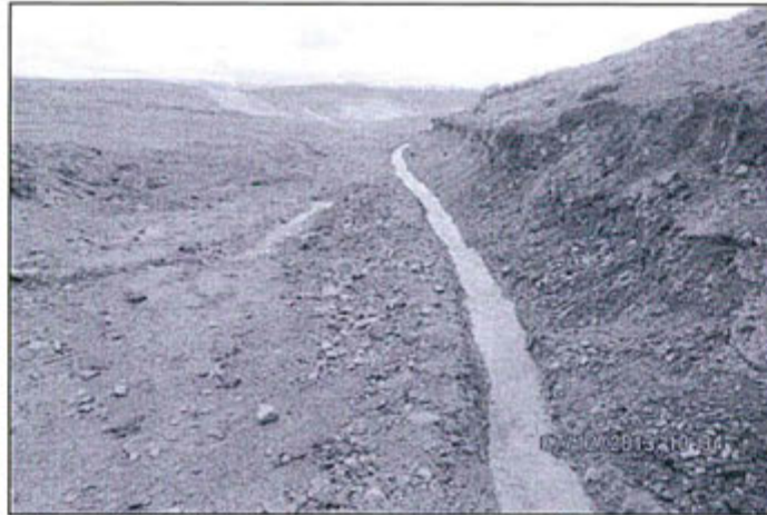
Fotografía N° 38: Canal de terreno natural que conduce el efluente pozas de sedimentación de las aguas de mina tratadas de la bocamina Vetas El Diablo (El Santo).
