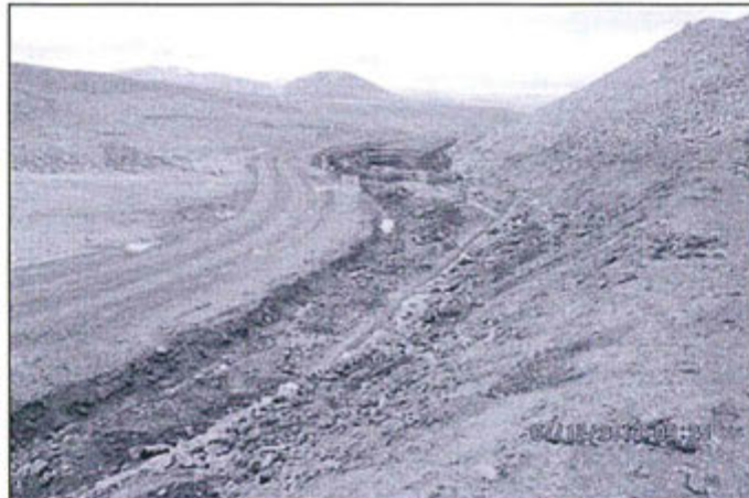
Fotografía N° 97: Canal de derivación y captación de drenajes del depósito de desmontes contemplado en el EIA Suyckutambo.
