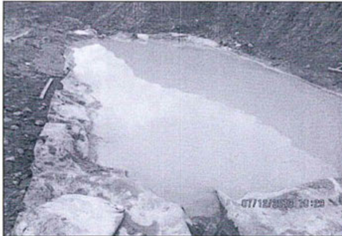
Fotografía N° 32: Pozas de descarga y tratamiento de aguas de mina de la bocamina vetas El Diablo (El Santo) nivel 0
