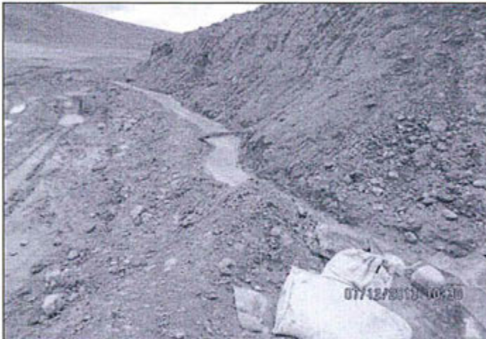
Fotografía N° 33: Canal que conduce las aguas de mina tratadas de la bocamina Vetas El Diablo (El Santo) a pozas de sedimentación
