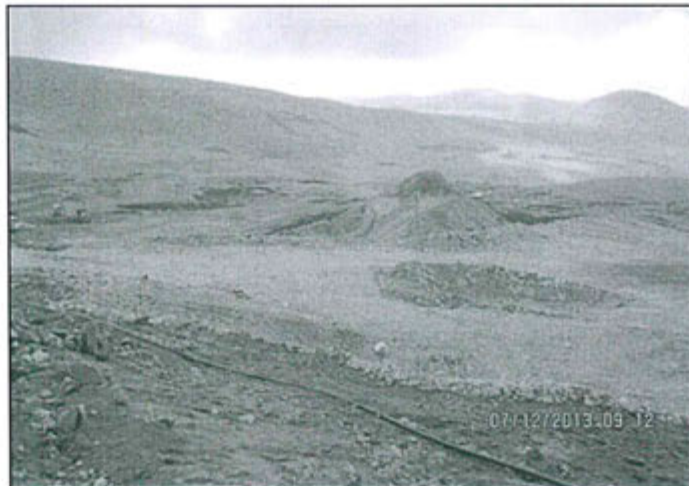
Fotografía N° 90: Depósito de desmontes no contemplado en el EIA de la U. M. El Diablo sin canal de coronación. Poza de lodos de tratamiento de aguas de mina.
