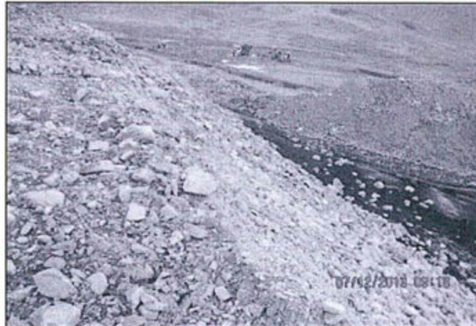
Fotografía N° 92: Talud del Depósito de desmontes no contemplado en el EIA de la U. M. El Diablo sin canal de coronación ni derivación de aguas de escorrentía.
