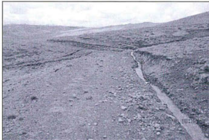
Fotografía N° 39: Canal de terreno natural que conduce el efluente pozas de sedimentación de las aguas de mina tratadas de la bocamina Vetas El Diablo (El Santo).
