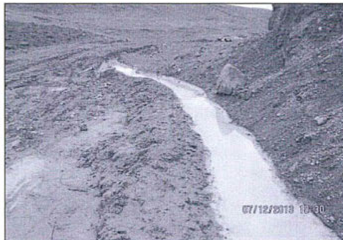
Fotografía N° 34: Canal que conduce las aguas de mina tratadas de la bocamina Vetas El Diablo (El Santo) a pozas de sedimentación.
