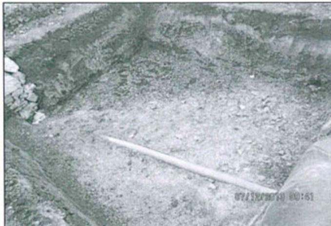
Fotografía N° 107: Poza en construcción para sedimentación de drenajes tratados del depósito de desmontes.
