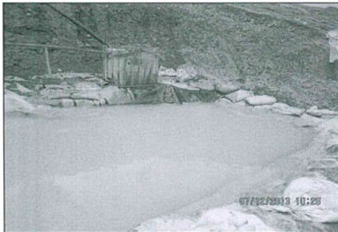
Fotografía N° 30: Pozas de descarga y tratamiento de aguas de mina de la bocamina vetas El Diablo (El Santo) nivel 0
