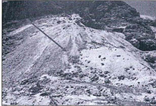
Fotografía N° 111: Depósito de desmontes o de material de préstamo frente al almacén de "top soil" en Suyckutambo, que no está autorizado.
