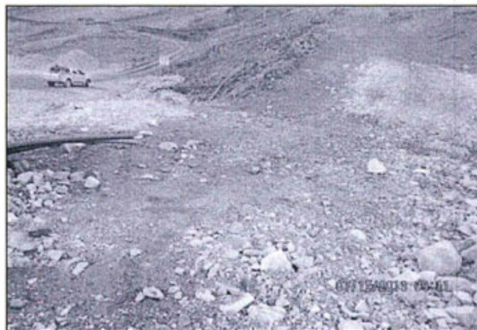
Fotografía N° 87: Depósito de desmontes no contemplado en el EIA de la U. M. El Diablo, sin canal de coronación.
