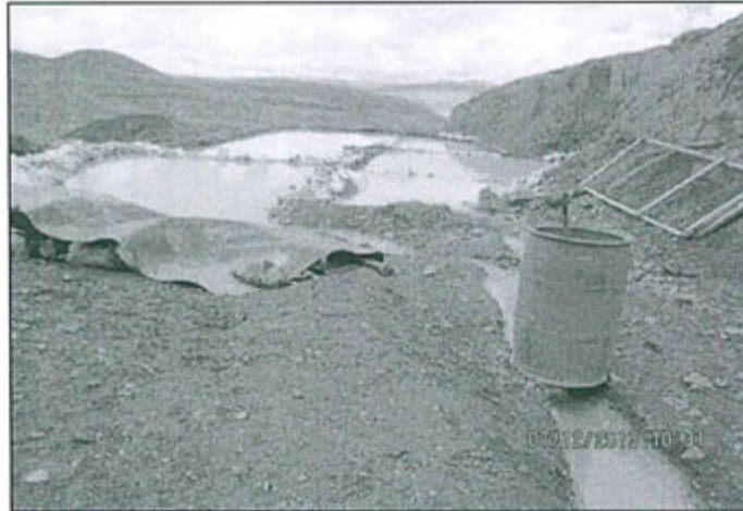
Fotografía N° 35: Pozas de sedimentación de las aguas de mina tratadas de la bocamina Vetas El Diablo (El Santo) nivel 0.
