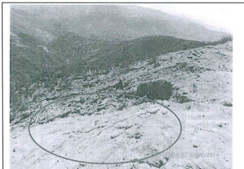
Fotografía N° 16: Plataforma sin bloque de cemento. Ubicada en las coordenadas UTM Datum WGS-84 9 093877N 765222E. En la parte baja de la plataforma se encuentra erosionada y también existe material (suelo y rocas) dispuesto sobre la vegetación.
