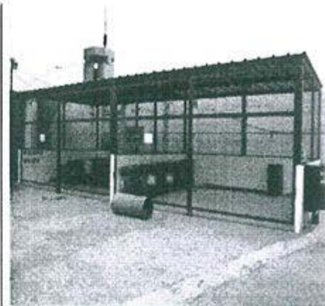
Fig. 20: Vista exterior del almacén temporal de residuos sólidos peligrosos
