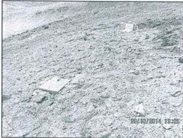
Fotografía N° 07.- Sondaje NIL 12-01 (Coordenadas UTM Datum geodésico WGS 84: 403 694E, 388 930N), perforada, cerrada y colocada dado de concreto con las especificaciones del caso, falta revegetación de la plataforma.
