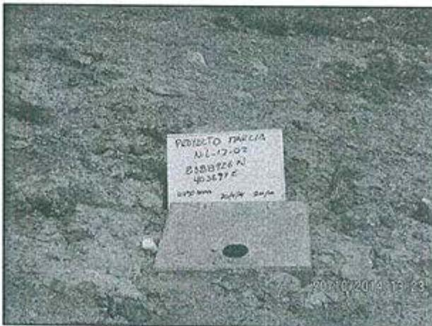
Fotografía N° 08.- Sondaje NIL 12-02 de la zona Nilda (Coordenadas UTM Datum geodésico WGS 84: 403 697E, 388 926N), perforada, cerrada y colocada dado de concreto con las especificaciones.
