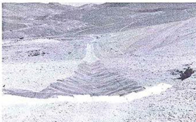
Fotografía N° 189: Hallazgo N° 1: Durante el desarrollo de la supervisión se verificó que el titular minero realizó el revestimiento mediante la colocación de geomembrana en el tramo del canal indicado en las coordenadas UTM Datum WGS 84; 8 029 192 N y 413964 E.
