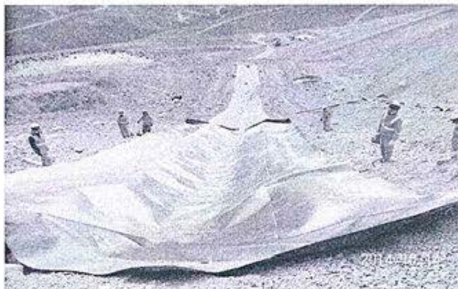
Fotografía N° 188: Hallazgo N° 1: Durante el desarrollo de la supervisión se verificó que el titular minero realizó el revestimiento mediante la colocación de geomembrana en el tramo del canal indicado en las coordenadas UTM Datum WGS 84; 8 029 192 N y 413964 E.
