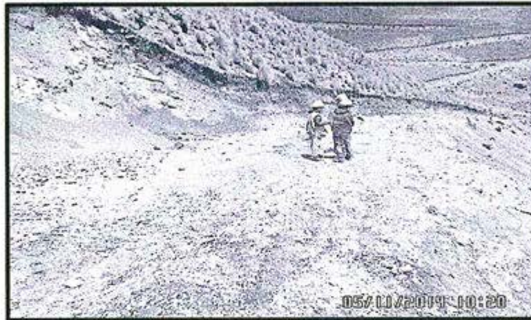
Fotografía N° 9: Vista de la plataforma PL-02 de 10 m de largo por 6 m de ancho aproximadamente, construida en el Área 1. Ubicado en las coordenadas N8832508, E 314510-WGS84
