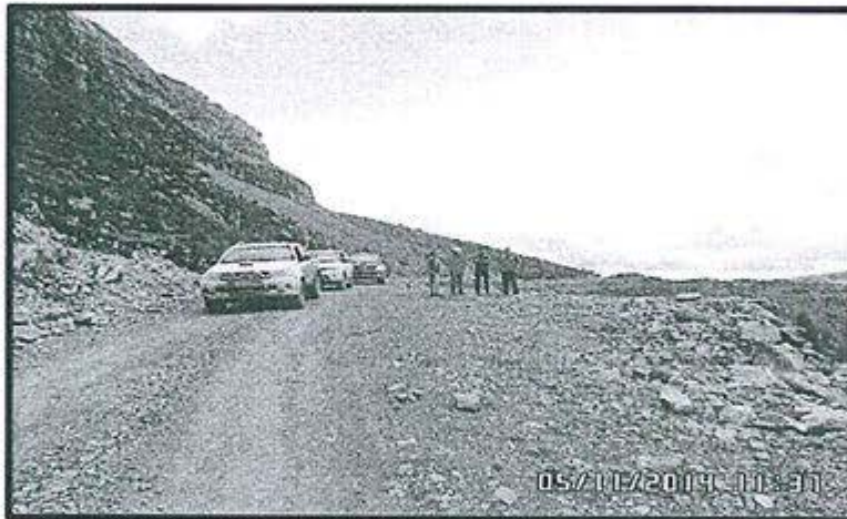
Fotografía N° 21: Vista de la plataforma PL-09 de 8 m de largo por 4 m de ancho aproximadamente, construida en el Área 2 pegado a la vía de acceso UEA Marisol. Ubicado en las coordenadas N8832278, E313630 – WGS84
