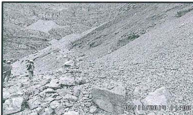
Fotografía N° 16: Vista panorámica de la vía de acceso ACC-4 de 3m de ancho y 100m de longitud aproximadamente. Este acceso se encuentra colapsado por derrumbe. Ubicado en las coordenadas N8833305, E313094 – WGS84
