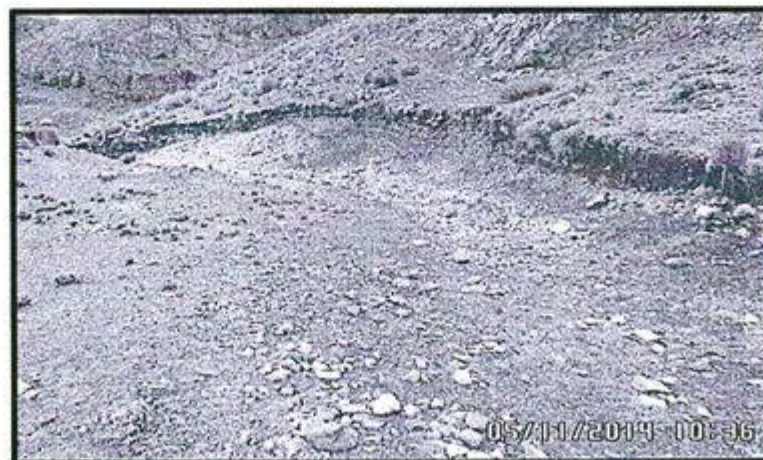
Fotografía N° 15: Otra vista de acceso ACC-01 de 4m de ancho y 100m de longitud aproximadamente, donde se observan taludes de corte entre 0.50 y 1.50m de alto. Ubicado en las coordenadas N8832458, E314449 – WGS84.
