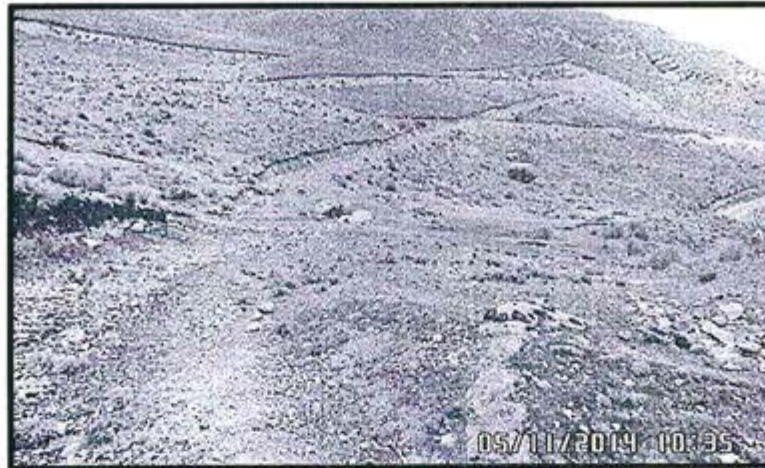
Fotografía N° 13: Vista panorámica de la vía de acceso ACC-01 de 4m de ancho y 100 de longitud aproximadamente. Ubicado en las coordenadas N8832458, E31449-WGS84
