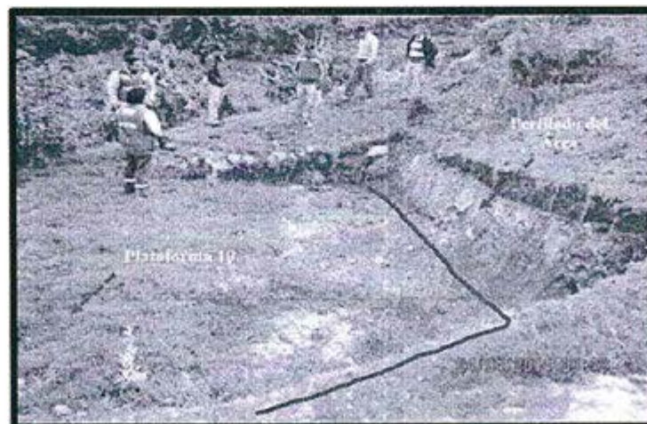
Fotografía N°10.- Vista de la plataforma N° 10. Se observa el perfilado del área y revegetación natural
