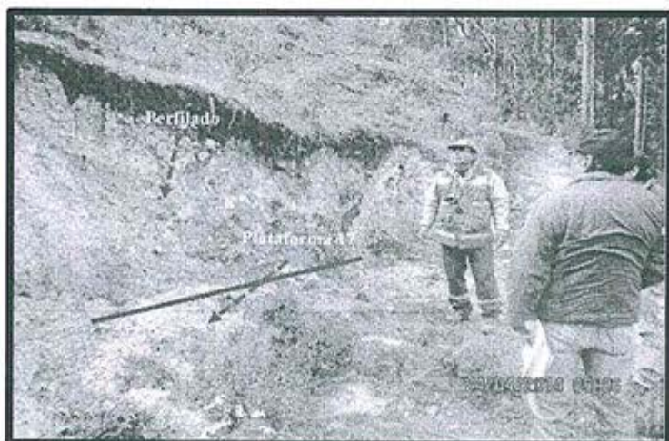
Fotografía N° 14.- Vista de la plataforma N° 17
