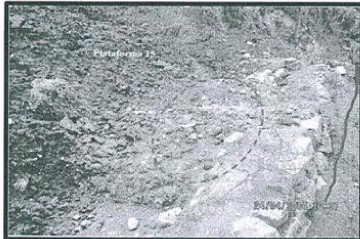
Fotografía N° 13.- Vista de la plataforma N° 15. Se observa deslizamiento de materiales rocosos, probablemente por la pendiente moderada y alta
