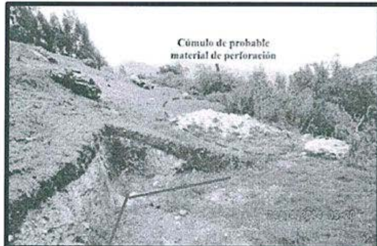
Fotografía N° 12.- Se aprecia en el área de la plataforma N° 10, en la parte lateral existe acumulación de material no determinado
