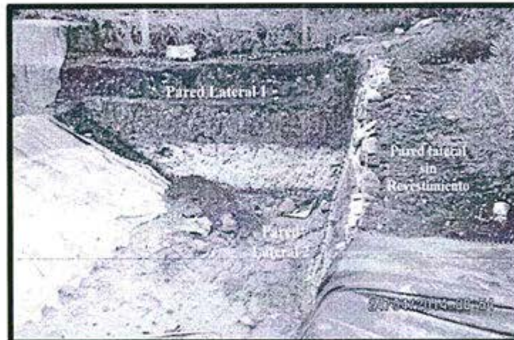
Fotografía N° 32.- La geomembrana de la pared lateral 1 y 2 ha sido cortada desde el nivel de los lodos (base)
