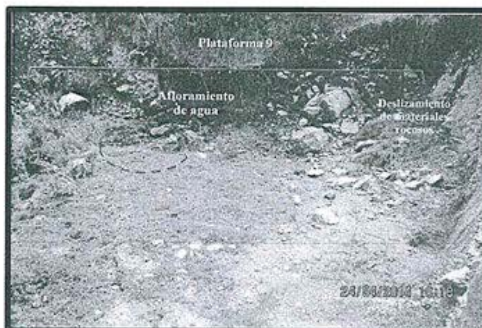
Fotografía N° 8.- Vista de la plataforma de perforación N° 9
