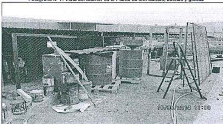
Es otra vista de la Fotografía N° 6 (Almacén temporal de residuos peligrosos ubicado cerca al área del proyecto de ampliación de la planta). Además se observa que se dispone productos químicos (tinta contenido pintura) sobre un muro de concreto colindante a suelo natural y en el estante de madera.
