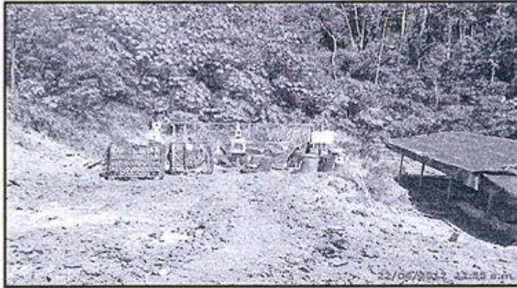
Fotografía N° 05: Pit de combustibles.
