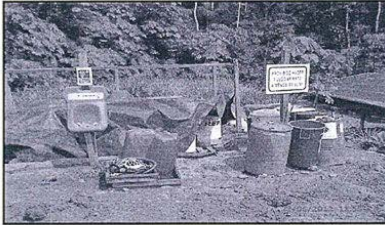
Fotografía N° 06: Pit de combustibles.
