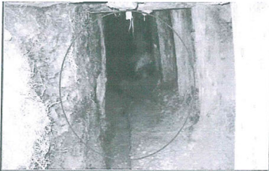
Fotografía N° 10.- Bocamina Mansita BM-5 – E.07, con coordenadas UTM – WGS 84 (N: 9252808; E: 765115).
