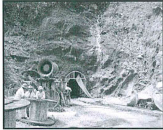
Fotografía N° 1: Se observa la construcción del túnel tipo ventana ubicado en la margen derecha de la ribera del río Uchubamba con coordenadas N 0472491 y E 8740190, de dimensiones 3 metros de ancho por 3.5 metros de altura por 670 metros de longitud aproximadamente. El mencionado lugar es el señalado también para la construcción del acceso para la caverna de máquinas de la C.H. Curibamba (de conformidad con el estudio de impacto ambiental que se encuentra en evaluación en la Dirección General de Asuntos Ambientales Energéticos del Ministerio de Energía y Minas.
