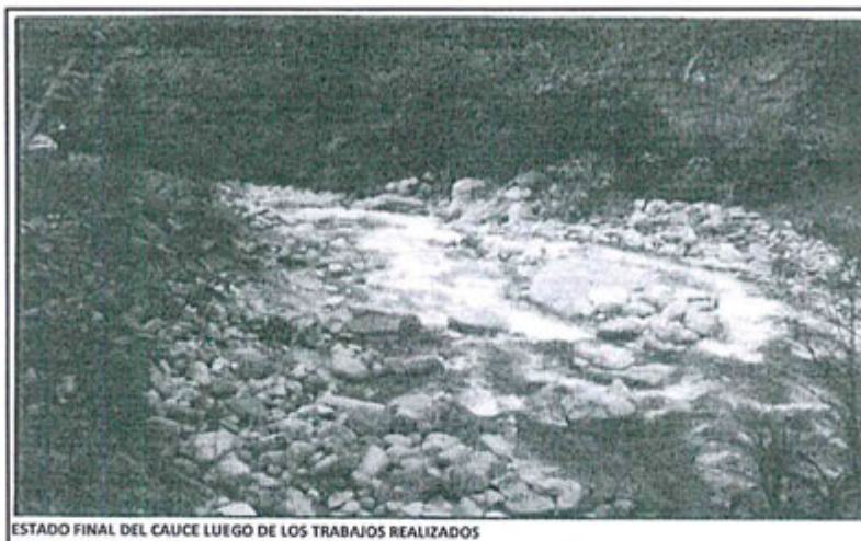
ESTADO FINAL DEL CAUCE LUEGO DE LOS TRABAJOS REALIZADOS
