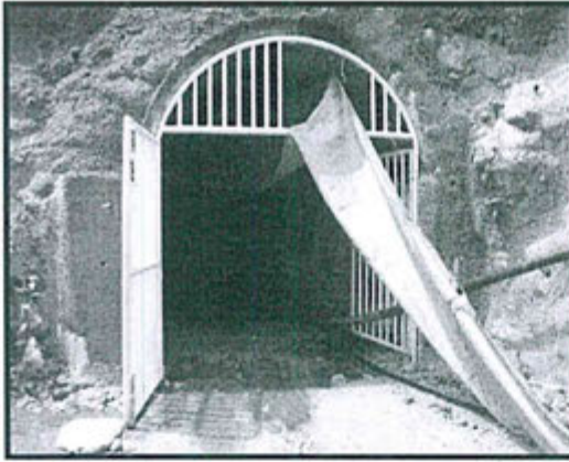
Fotografía N° 1: Se observa la construcción del túnel tipo ventana ubicado en la margen derecha de la ribera del río Uchubamba con coordenadas N 0472491 y E 8740190, de dimensiones 3 metros de ancho por 3.5 metros de altura por 670 metros de longitud aproximadamente. El mencionado lugar es el señalado también para la construcción del acceso para la caverna de máquinas de la C.H. Curibamba (de conformidad con el estudio de impacto ambiental que se encuentra en evaluación en la Dirección General de Asuntos Ambientales Energéticos del Ministerio de Energía y Minas.
