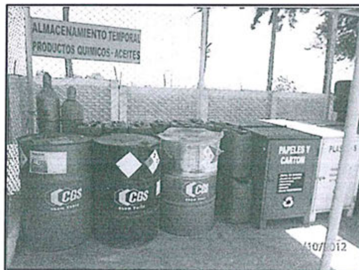
Vista 3 del Informe de Supervisión: Los residuos sólidos son almacenados cerca de productos químicos, estos residuos no cuentan con un sistema de canalización y tratamiento de lixiviados.
