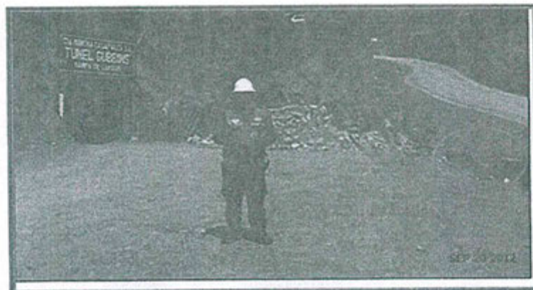
FOTOGRAFIA N° 258.- Observación N° 10 – 2012: En la Rampa de Carguío del túnel Gubbins ubicado en las coordenadas UTM: Este 365450, Norte 8711419 con datum WGS 84, se observó la disposición de mineral a un costado de la bocamina "Rampa de Carguío del túnel Gubbins", además la berna de seguridad de esta zona de carguío tiene una abertura hacia la quebrada.
