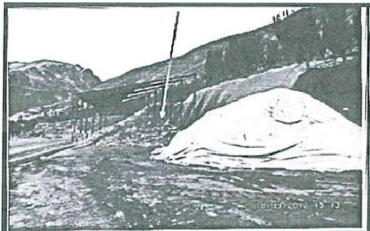
FOTOGRAFIA N° 215.- Se precisa el área donde se encuentra ubicado el stock pile (coordenadas UTM datum WGS 84: Este 0365720, Norte 8712350). Este componente no está contemplado en un instrumento de gestión ambiental que autorice su funcionamiento
