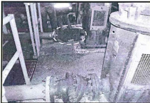
Fotografía N° 10 del Informe de Supervisión.- Sistema de válvulas de las cuales la N° 1 presentó la falla de la Válvula Chek.
