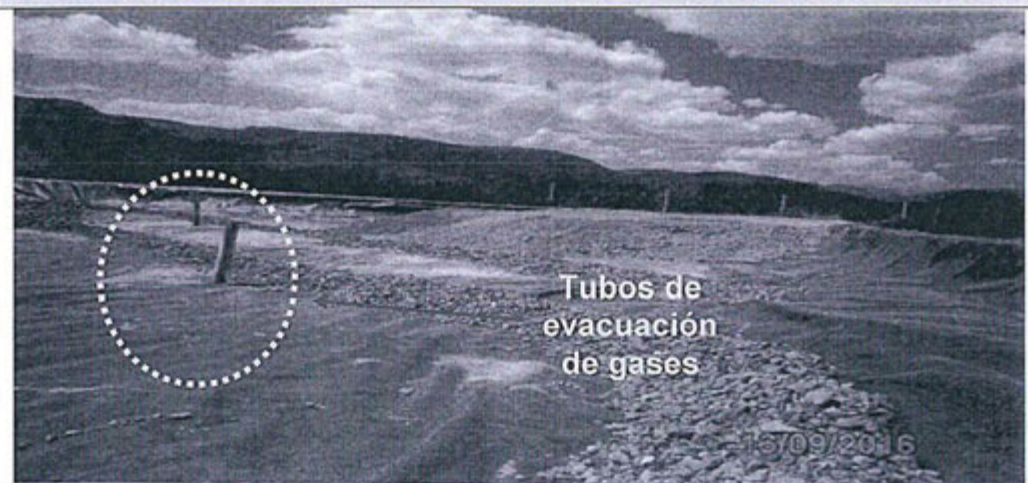
Imagen N° 10: Tubos de evacuación de gases
