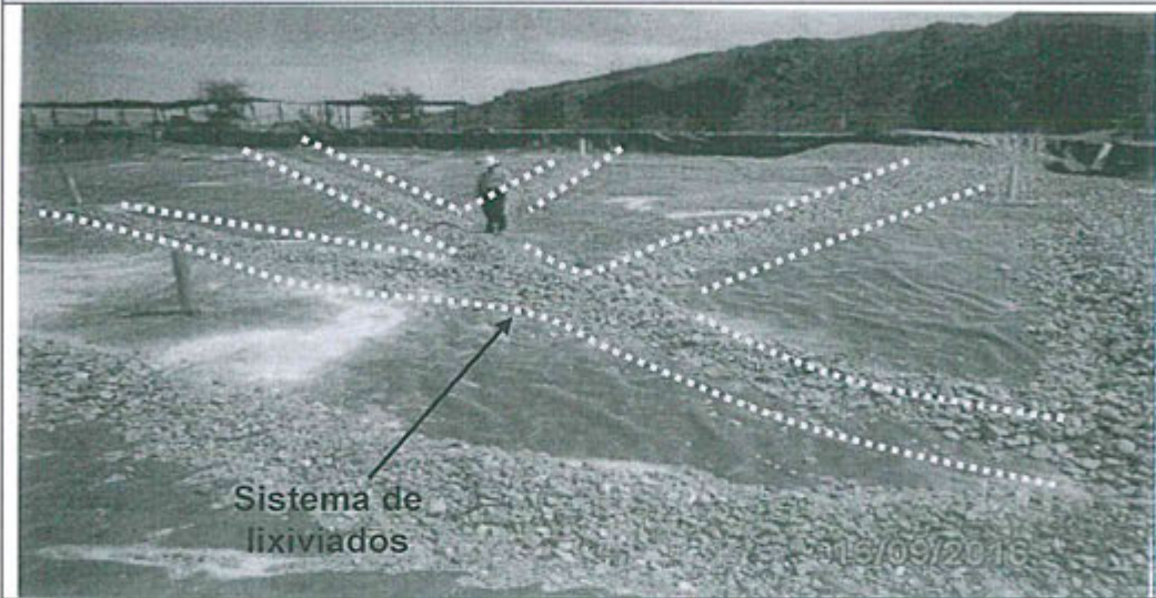
Imagen N° 7: Vista panorámica del relleno sanitario Antapite y el sistema de lixiviados (Coordenadas UTM WGS 84 0491284E, 8455868N Altitud de 3596m.s.n.m.)
