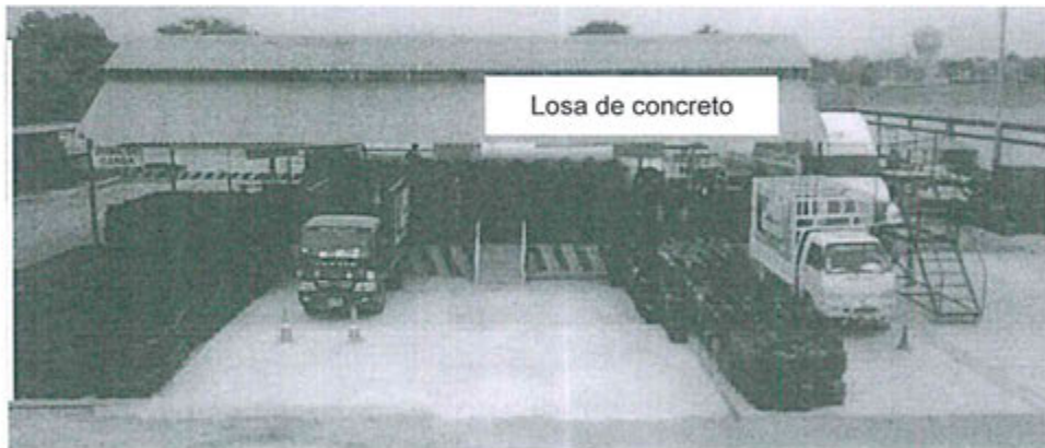
Fotografía N° 1.- Área de maniobra con losa de concreto
