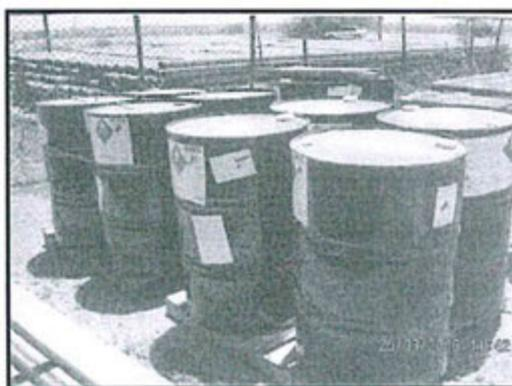
**Fotografía N° 2:** Vista del almacenamiento de 11 cilindros conteniendo Tetrolite DMO2532 Demulsificante en un área con el suelo no impermeabilizado.
