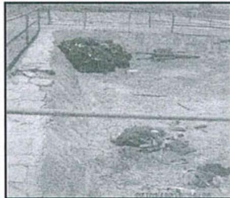
Fotografía N° 5: Vista del interior del área de almacenamiento de residuos peligrosos, obsérvese que el suelo no se encuentra impermeabilizado y existe una mala disposición de los residuos (sin contenedor).
