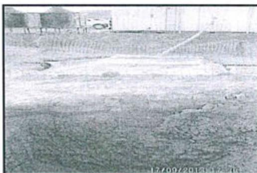
**Fotografía N° 67:** Vista del Tratamiento de Aguas Grises, obsérvese que se realiza mediante la disposición a una poza.
