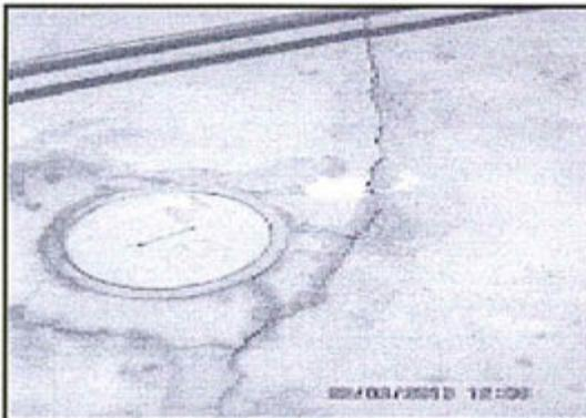
Fotografía N° 22: Vista de la zona de estanca de la **Batería 212**, obsérvese grietas en la losa de concreto.
