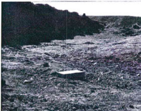
Fotografía N° 10 Obturación con la loseta de datos
