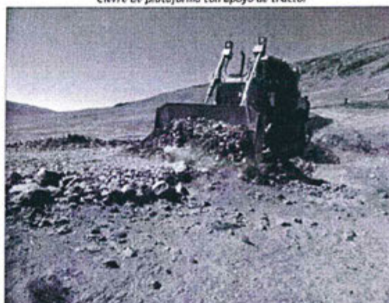
Fotografía N° 11 Cierre de plataforma con apoyo de tractor
