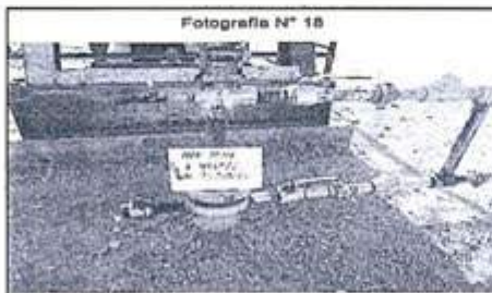
En el registro fotográfico se muestra al pozo 7048, el cual no contiene un sistema de contención, recolección, en el caso que sucediera una fuga y derrame de hidrocarburo. Asimismo, se halló ligeros en el cuadro estándar de producción.
