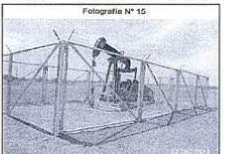
Vista panorámica del pozo 8224, alrededor del pozo se observa suelo impregnado con hidrocarburos y falta de un sistema de contención de fugas y derrames.
