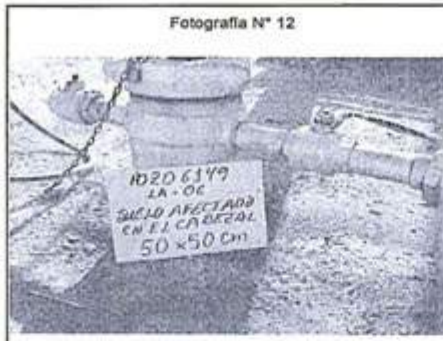
En el registro fotográfico se muestra al pozo 6149, el cual no contiene un sistema de contención, recolección, en el caso que sucediera una fuga y derrame de hidrocarburo. Se halló suelo impregnado con hidrocarburo alrededor de la boca de pozo.
