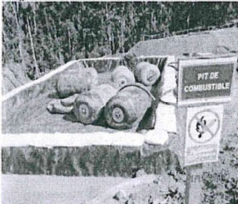
Fotografía N° 32: Inadecuado almacenamiento del combustible.
