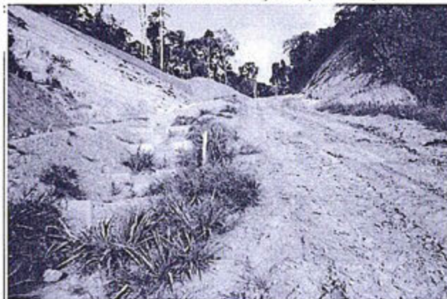
Foto N° 1.- Diques de sedimentación para control de erosión y trabajos de estabilización de taludes. Estos trabajos se repiten a lo largo del DoV.
