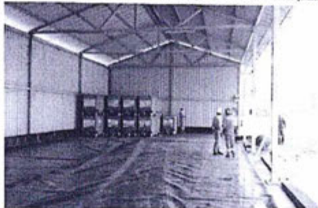
Fotografía del 14.08.2013 donde se visualiza la presencia de geomembrana en el almacén de químicos
