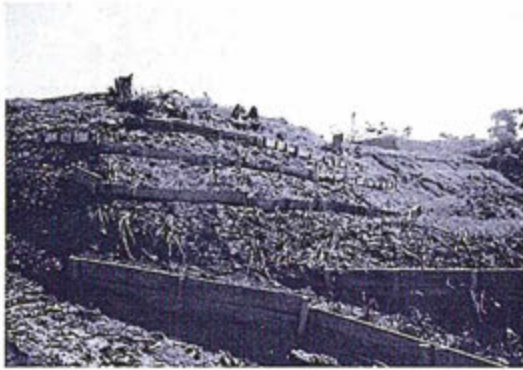
Foto N° 1.- Control de erosión para Top Soil con trincheras.
