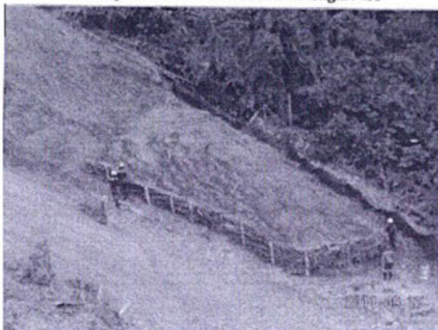
Trabajos de control de erosión en Sagari 4X
