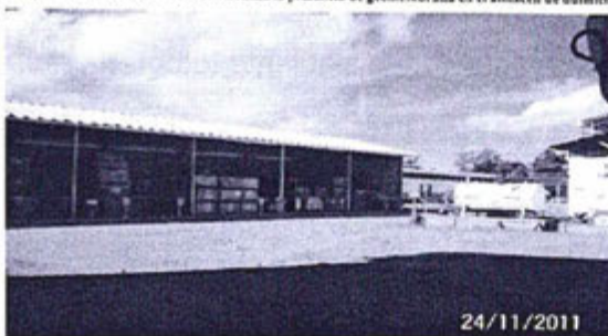
Fotografía del 24.11.2011 donde se visualiza la presencia de geomembrana en el almacén de químicos
