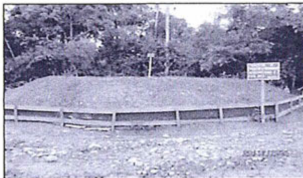
Fotografía N° 10: Inadecuada disposición del suelo orgánico
