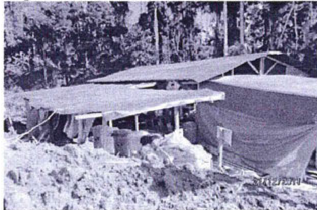
Se aprecia el almacén temporal de residuos sólidos de la locación Sagari, el cual no cuenta con una canaleta perimetral para evacuar las aguas pluviales.
