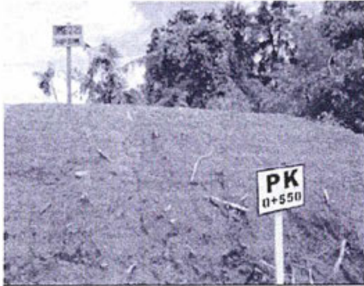
Se aprecia un depósito de material excedente se viene mezclando con el topsoil, tal como se aprecia en el cartel amarillo; además, estos depósitos no están adecuadamente conservados.
