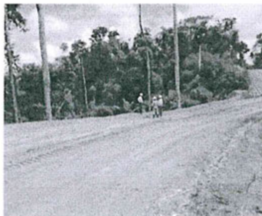
Fotografía N° 12: Derecho de vía excede el ancho establecido
