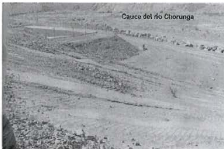
Foto N° 5.- En el depósito de relaves N° 1 se realizó un trabajo de estabilización con material de relaves de flotación (en primera plana), dicho trabajo no está contemplado en su EIA aprobado y representa un peligro ambiental al encontrarse a pocos metros del cauce del río.
