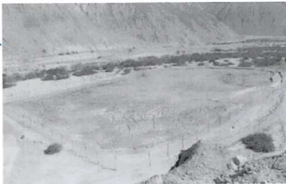
Foto N° 4.- El depósito de relaves CIL N° 1 de cianuración se encuentra en el área del depósito de relaves N° 5 de flotación, dicho depósito de relaves no se encuentra contemplado en el EIA aprobado.
