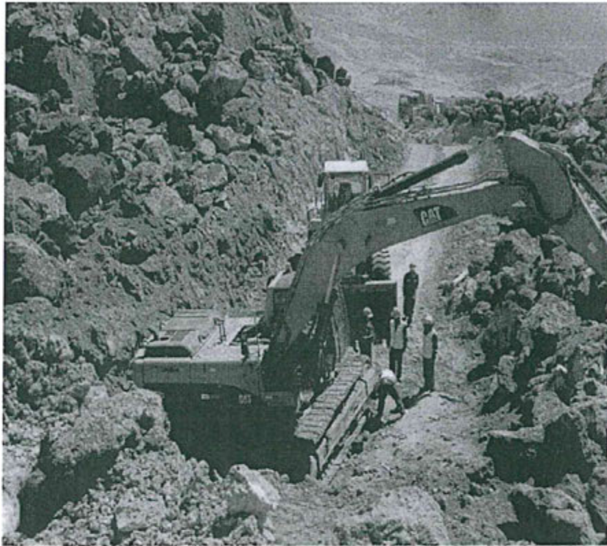
Foto N° 13. Maquinaria conformada por excavadoras, cargador frontal, volquetes y otros operando en el tajo de la Concesión Magnetita (...)
