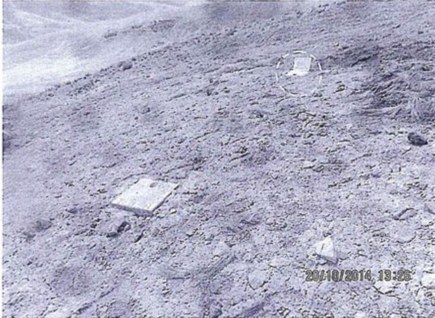
Fotografía N° 07.- Sondaje NIL 12-01 (Coordenadas UTM Datum geodésico WGS 84: 403 694E, 8 388 930N), perforada, cerrada y colocada dado de concreto con las especificaciones del caso, falta revegetación de la plataforma.
