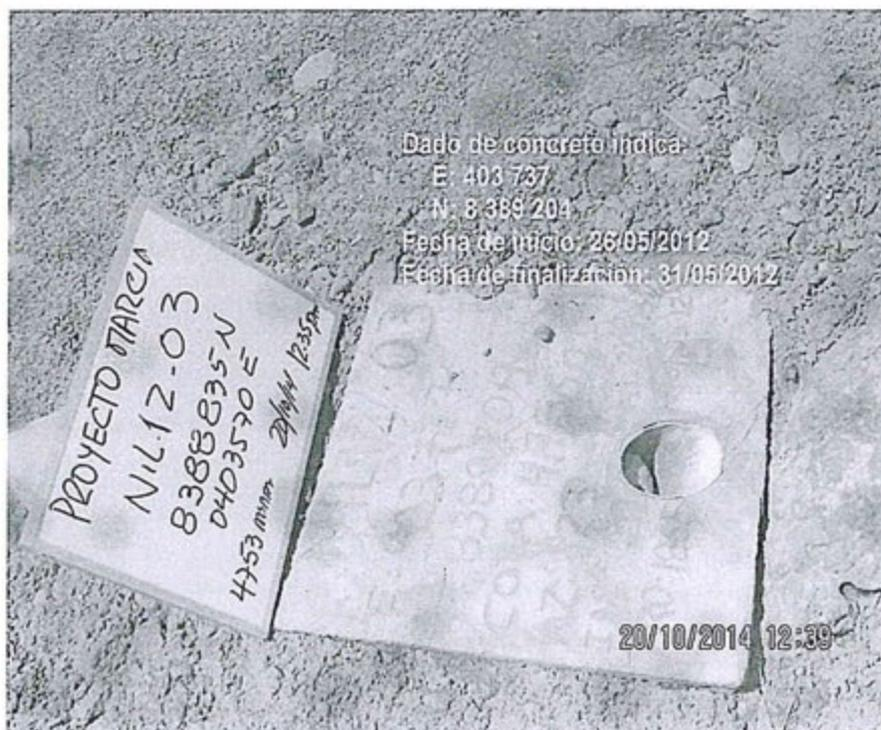
Fotografía N° 03.- Sondaje NIL 12-03, cerrado y colocado dado de concreto.
