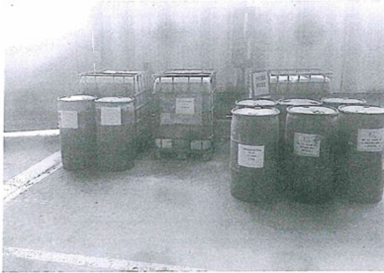
Almacenamiento de Concentrado de Espuma en Área estanca, dentro del almacén General de materiales
