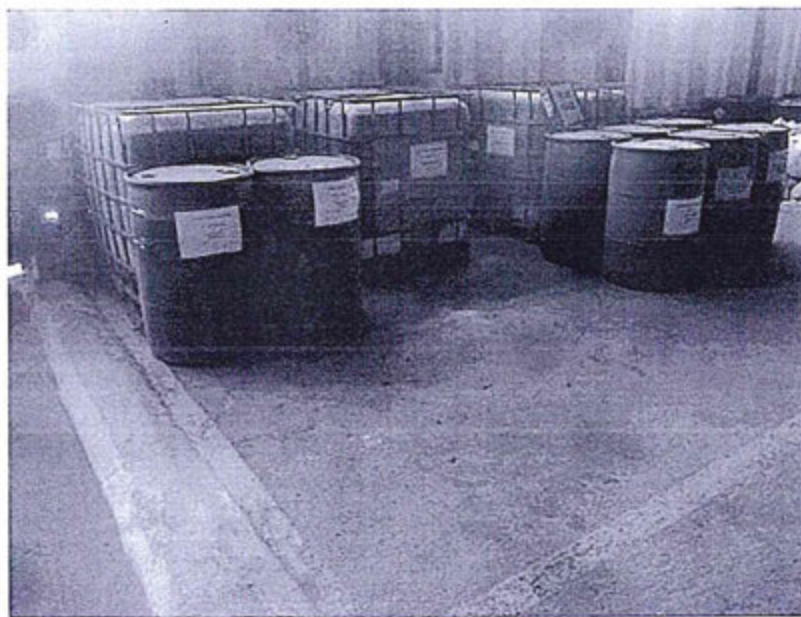
Esquina inferior izquierda se observa el muro de contención de la zona estanca
