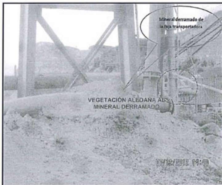
Foto N° 71: Observación N° 02-2012. Otro sector de los derrames producidos desde la faja transportadora sobre el suelo.
