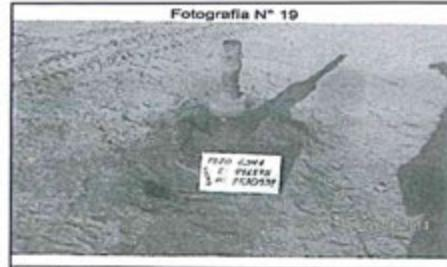
En el registro fotográfico se muestra al pozo 6341, el cual no contiene un sistema de contención, recolección, en el caso que sucediera una fuga y derrame de hidrocarburo. Asimismo, se halló suelo impregnado con hidrocarburo alrededor de la boca de pozo.
