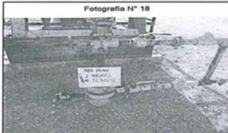
En el registro fotográfico se muestra al pozo 7048, el cual no contiene un sistema de contención, recolección, en el caso que sucediera una fuga y derrame de hidrocarburo. Asimismo, se halló líquida en el cuadro estándar de producción.
