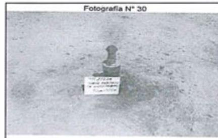
En el registro fotográfico se muestra al pozo 10229, el cual no contiene un sistema de contención, recolección, en el caso que sucediera una fuga y derrame de hidrocarburo. Asimismo, se halló suelo impregnado con hidrocarburo alrededor de la boca de pozo.
