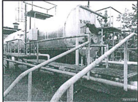
FOTO N° 53: E0174682 N9724435/ Topping Plant.
