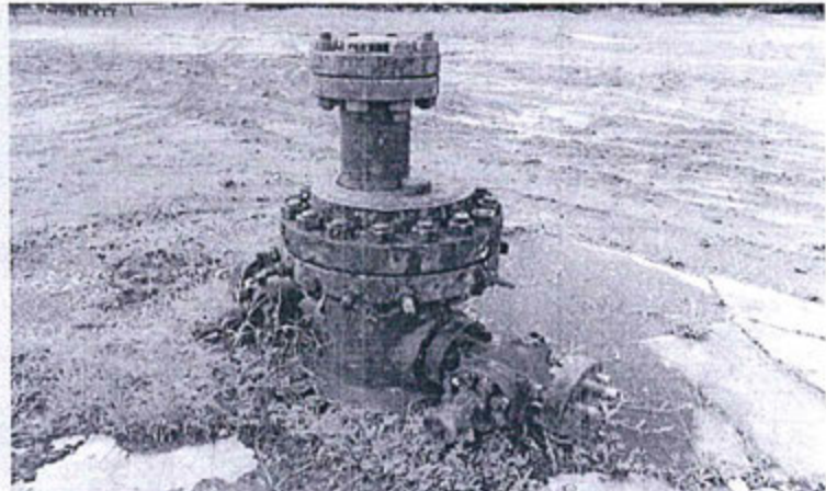
FOTO N° 282: E342281 N9690133 (PSAD 56) / Pozo CS28 – Capahuari Sur.
