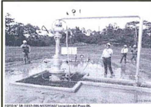
FOTO N° 58: E037-006 N9728560/ Ubicación del Pozo 06.
