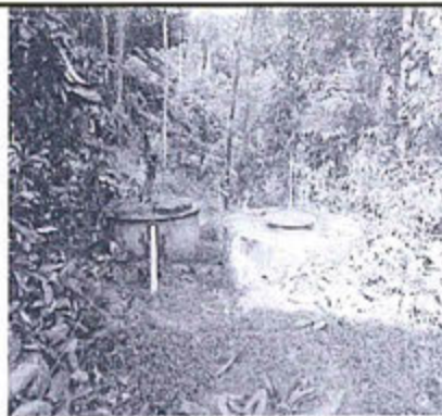
FOTO N° 67: E334010 N9702600 (PSAD 56) / Tanque que almacenan los efluentes líquidos domésticos de Capahuari Norte.
