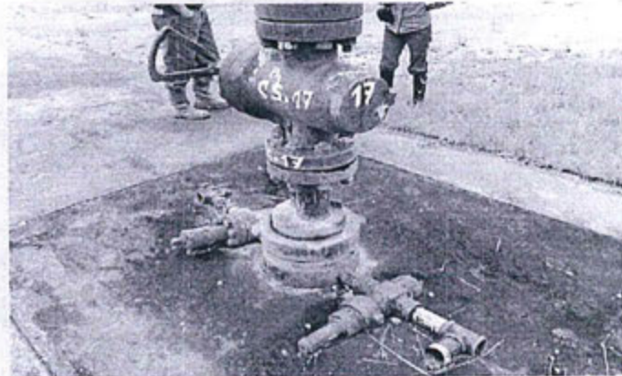
FOTO N° 281: E340957 N9690720 (PSAD 56) / Pozo CS17 – Capahuari Sur.
