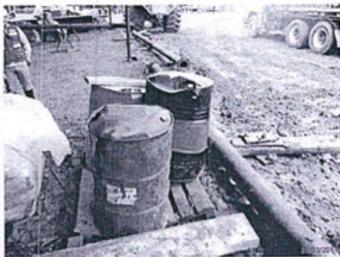
FOTO N° 94: E0373699 N9723602/ Área de Construcciones.
