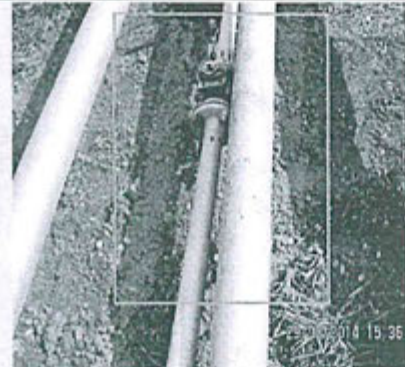
FOTO N° 258: E363010 N9712342 / Área Rehabilitado - Línea de Diesel Bateria Huayuri / Yacimiento Huayuri.
