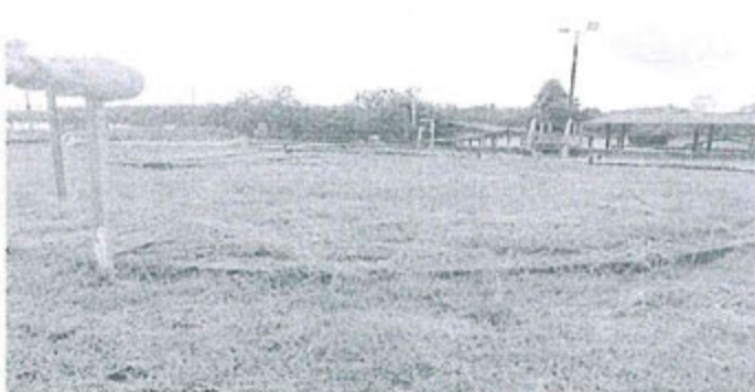
FOTO N° 275: E338477 N9689563 (PSAD 56) / Patio de tanques de combustibles - Andoas.
