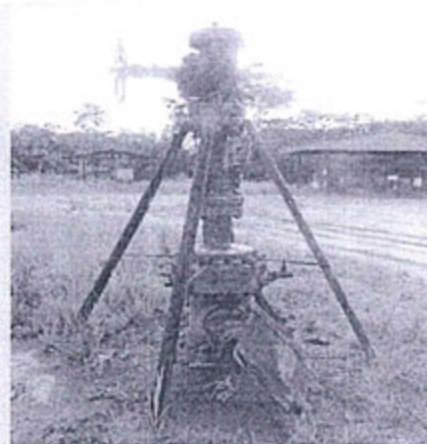
FOTO N° 283: E342164 N9690769 (PSAD 56) / Pozo CS8 – Capahuari Sur.
