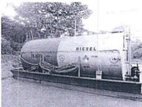
FOTO N° 82: E332759 N9706270 (PSAD 56) / Locación del pozo CN12 - Capahuari Norte.
