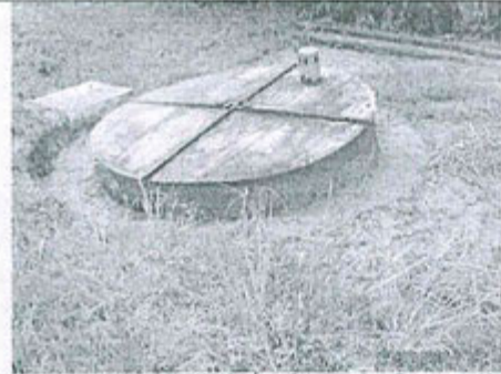
FOTO N° 256: E363010 N9712342 / Área Rehabilitado - Tanque sumidero del Pozo 5 / Yacimiento Huayuri.
