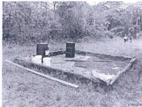
FOTO N° 111: E0362328 N0730122/ Locación de los Pozos 1504, 1508 y 1509.
