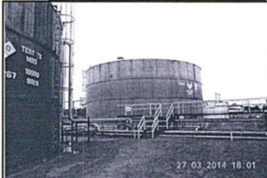
FOTO N° 33: E9403698 N9744315 / Área Estanca de Batería San Jacinto
