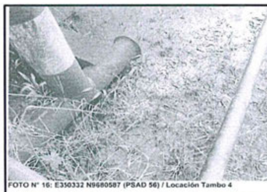
FOTO N° 16: E350332 N9680587 (PSAD 56) / Locación Tambo 4
