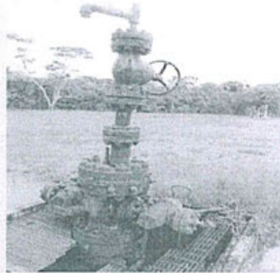
FOTO N° 279: E340973 N9690670 (PSAD 56) / Pozo CS10 – Capahuari Sur.
