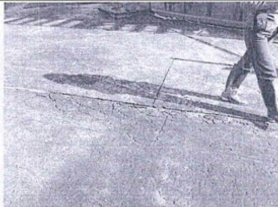
FOTO N° 264: E341737 N9690362 / Planta de reinyección de Capahuari
