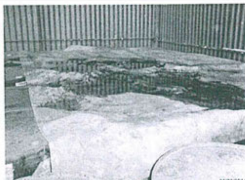
FOTO N° 121: (0375750 N9713131/ Área I del Almacén de Químicos.
