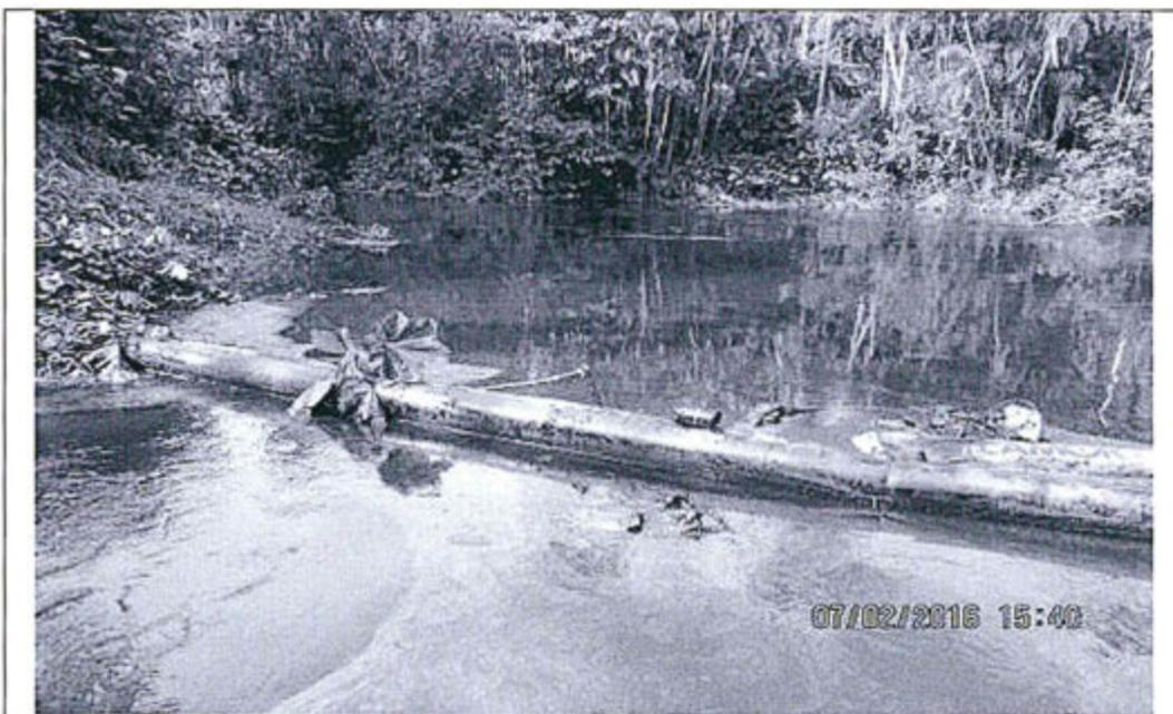
Foto 16: Muestra la primera barrera de contención ubicada a unos 500m aproximadamente aguas adentro de la Quebrada Cashacaño, se observa delante de la barrera una mínima presencia de crudo retenido, y arrastre de crudo después de la barrera de contención debido a la fuerte corriente que presenta en este punto la referida Quebrada. Coordenada WG84: 9526887N/0251184E.
