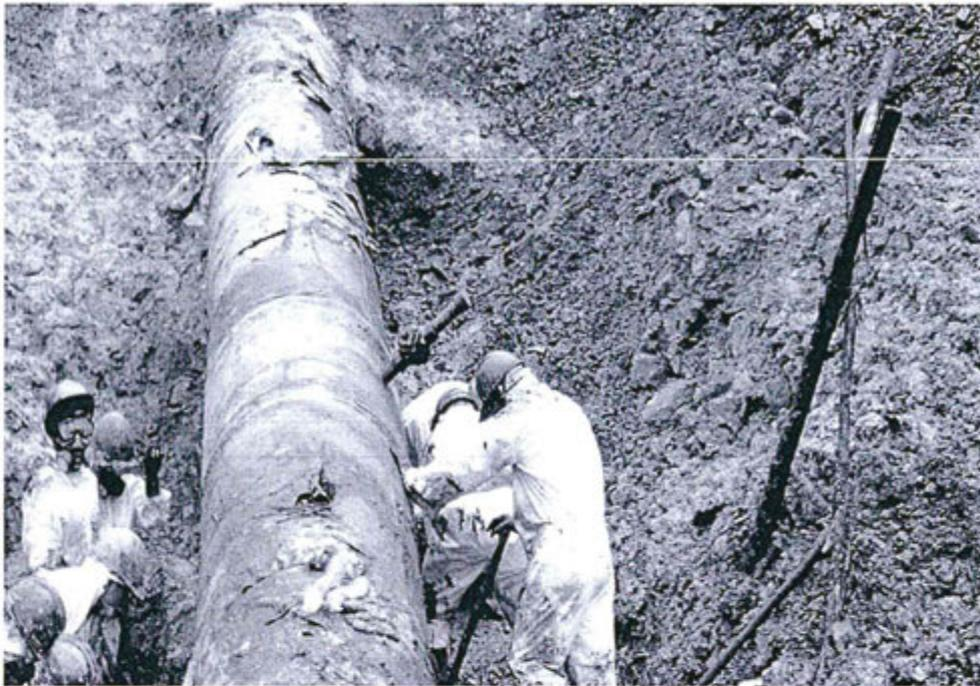
Foto 12: Vista cercana de zona de la tubería por donde fugaba el petróleo crudo, se observa una plancha metálica soldada a la tubería con un tapón y una válvula de 2" de diámetro.
