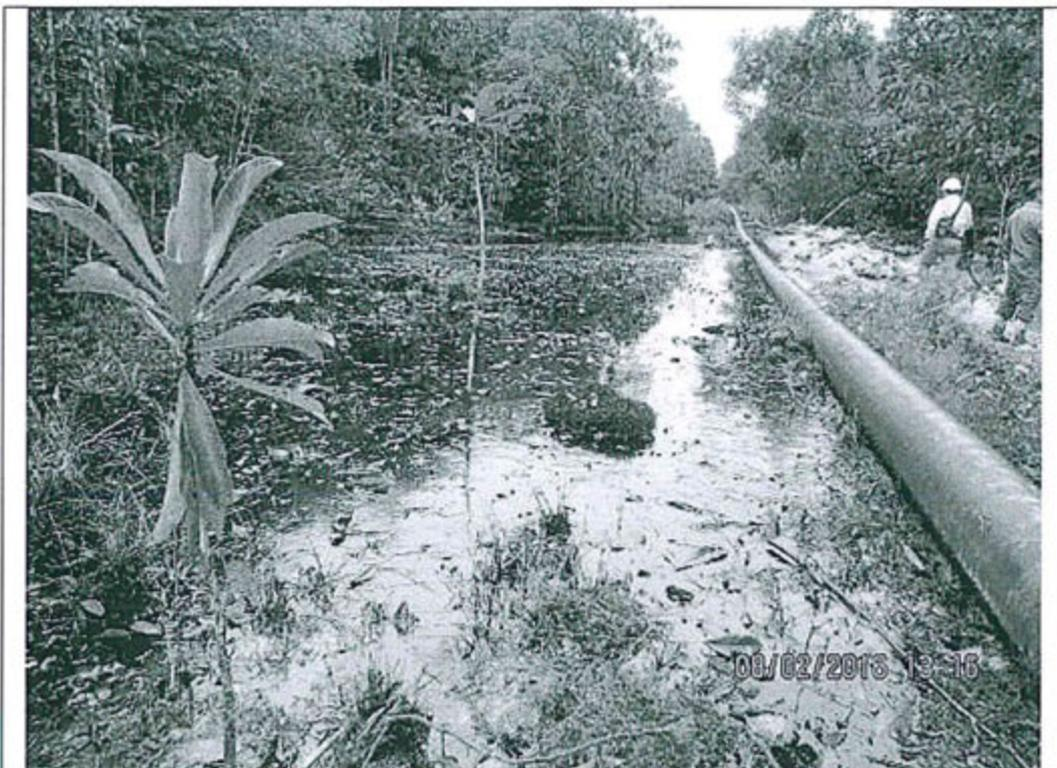
Foto 21: Muestra el área afectada en el punto donde se produjo el derrame de petróleo crudo por falla en el oleoducto. Coordenada WG84: 9524314N/0237150E.
