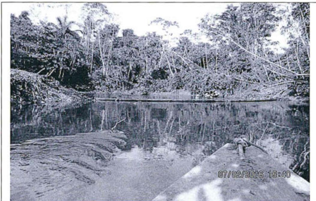
Foto 15: Muestra la primera barrera de contención ubicada a unos 500m aproximadamente aguas adentro de la Quebrada Cashacaño, se observa delante de la barrera una mínima presencia de crudo retenido, y arrastre de crudo después de la barrera de contención debido a la fuerte corriente que presenta en este punto la referida Quebrada. Coordenada WG84: 9526887N/0251184E.
