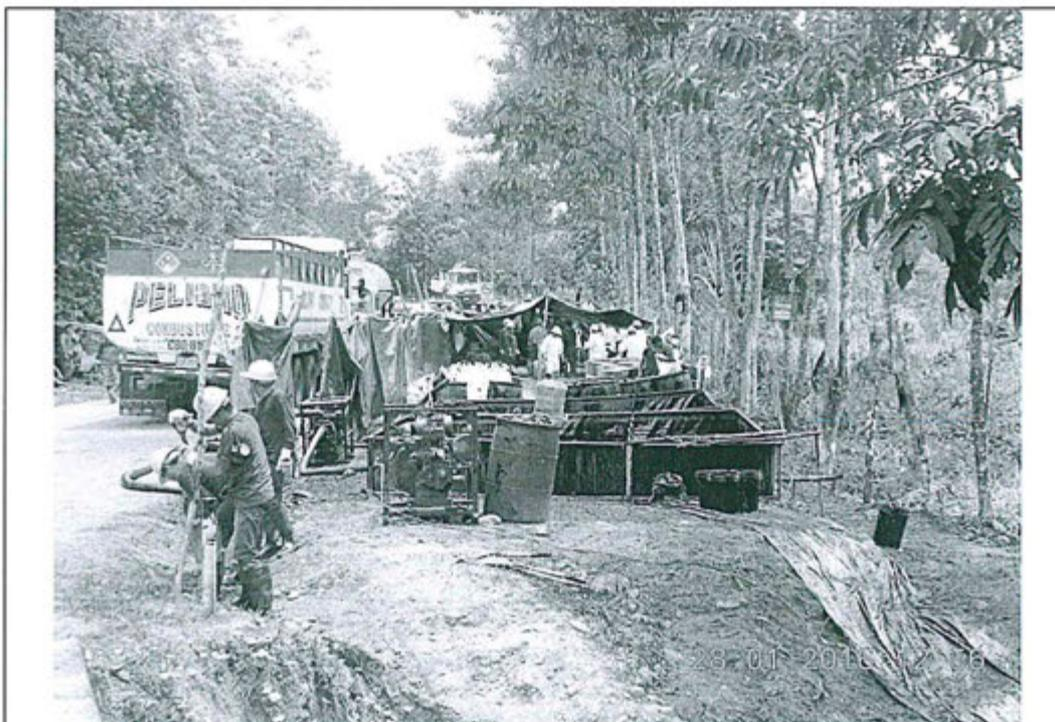
Foto 16: Vista de personal de PETROPERU, realizando actividades de movimiento del petróleo crudo recuperado. Se observa un camión cisterna que trasladará el petróleo crudo hasta la Estación 6, para su reinyección en el transporte.
