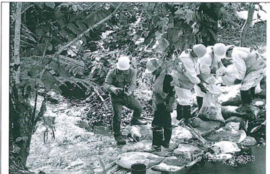
Foto 8: Muestra los trabajos que viene realizando la empresa PETROPERÚ instalando barreras de contención en el cauce de la quebrada Inayo, aguas abajo del punto del derrame. Además, se observa a un especialista del OEFA tomando muestras de agua superficial en la mencionada quebrada.
