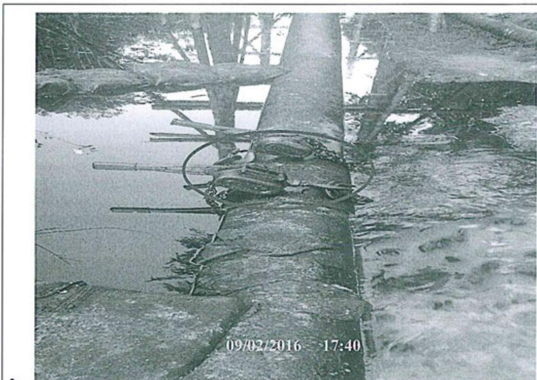
Foto 31: Muestra punto del derrame totalmente controlado mediante la instalación de una grampa.
