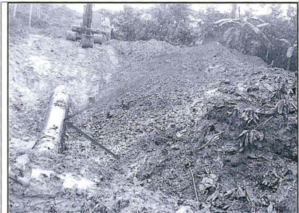
Foto 2: Se observa que el petróleo crudo no ha sido controlado, y se sigue realizando movimiento de tierra de la tubería en el Punto de falla.
