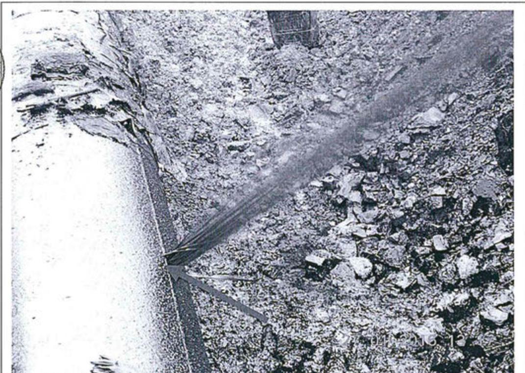
**Foto 3:** Se observa que el petróleo crudo está saliendo por una "falla" de la tubería de 36" de diámetro.
