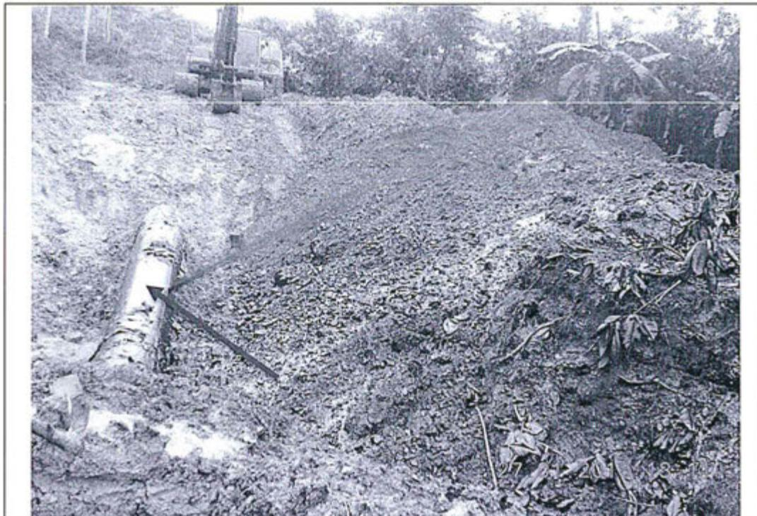
**Foto 2:** Se observa que el petróleo crudo no ha sido controlado, y se sigue realizando movimiento de tierra de la tubería en el Punto de falla.
