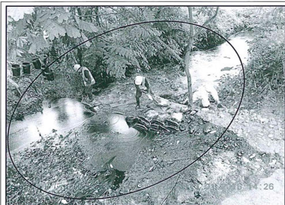
Foto 6: Desplazamiento del hidrocarburo derramado en el mes de enero del 2016 en el Oleoducto Norperuano, el cual sigue el curso de la quebrada Inayo.
