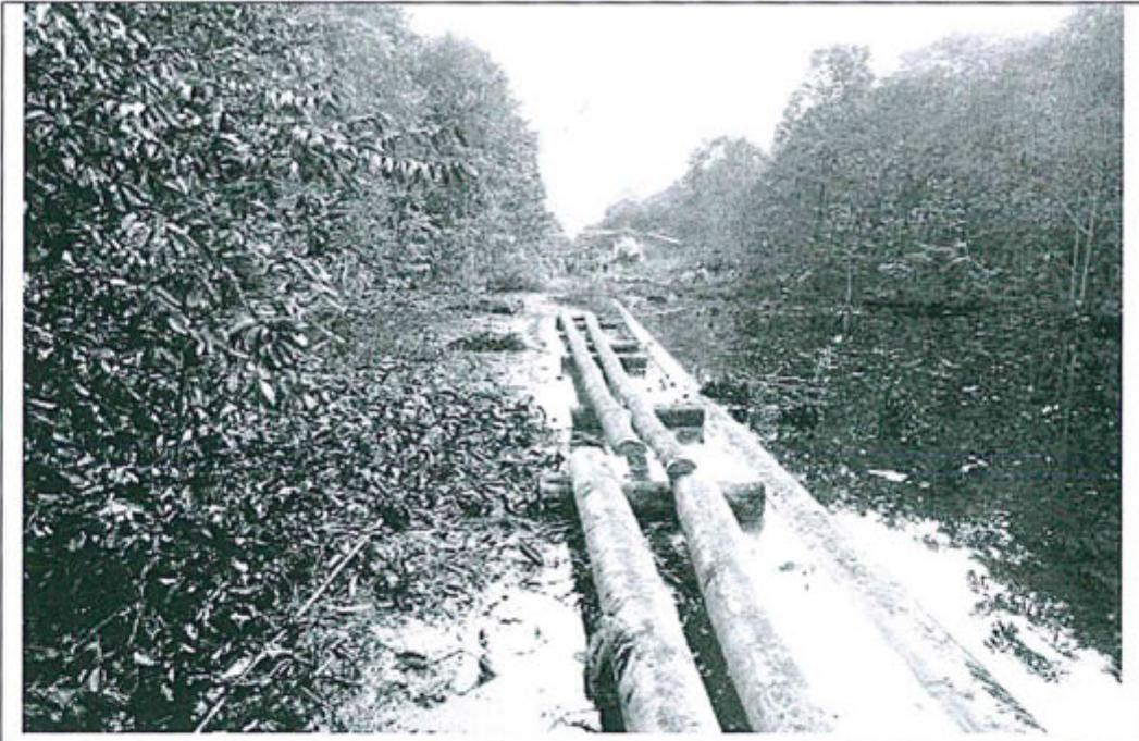
Foto 19: Muestra el área afectada en el punto donde se produjo el derrame de petróleo crudo por falla en el oleoducto. Coordenada WG84: 9524314N/0237150E.
