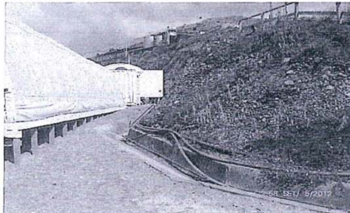
Foto N° 12: Vista de la ruta y canal pluvial de concreto por donde discurrió el derrame de Biodiesel y los residuos de lavado (Observación N° 5)
