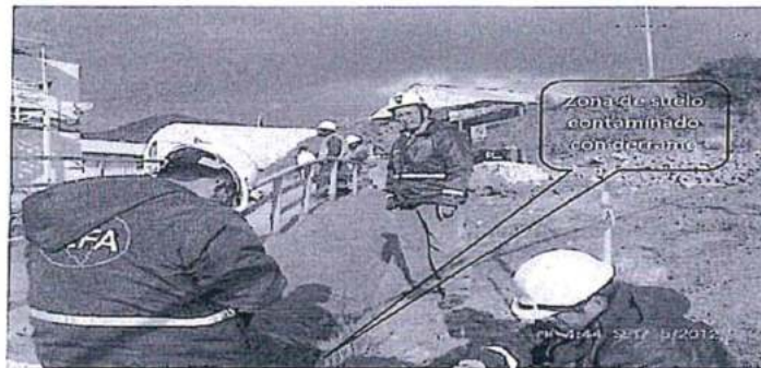
Foto N° 6: Vista de otra zona de suelo contaminado con derrame de hidrocarburo que falta ser limpiado contigua y aguas abajo de la cuneta de cemento para agua pluvial (Observación N° 1)
