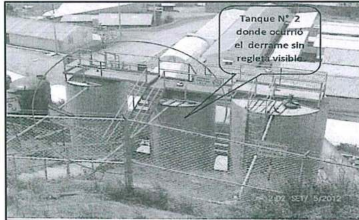
Foto N° 7: Vista de los Tanques de almacenamiento N° 3 y N° 2 sin regleta visible desde el borde de la plataforma de descarga de Biodiesel. Tampoco tienen rótulo con numeración y capacidad (Observación N° 2 y N° 3)
