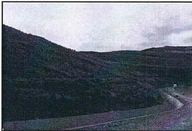
Foto 08: Canal de coronación construido en el depósito de desmonte norte.
