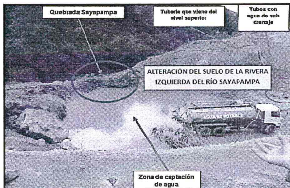
Fotografía N° 8: Zona de captación de agua de escorrentía y subdrenaje (poza de monitoreo de subdrenaje), ubicada al borde de la quebrada Sayapampa, no tiene impermeabilización ni dimensiones definidas.
