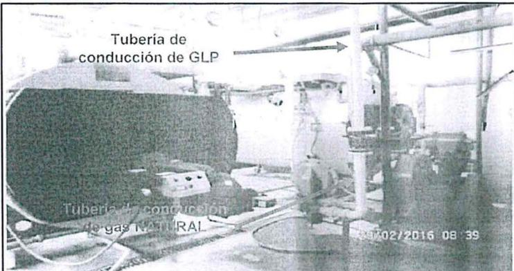
Vista del sistema de tuberías (color amarillo) que alimenta el primer caldero con gas natural y gas licuado de petróleo.
