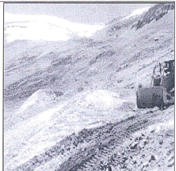
Fotografía N° 2: Reperfilado de la superficie y estabilización de los taludes.
