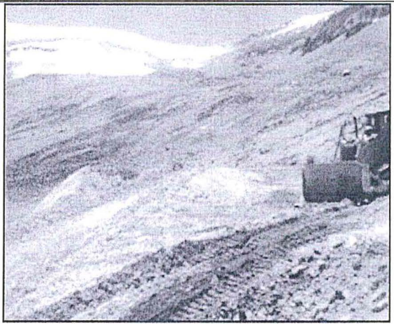
Fotografía N° 2: Reperfilado de la superficie y estabilización de los taludes.
