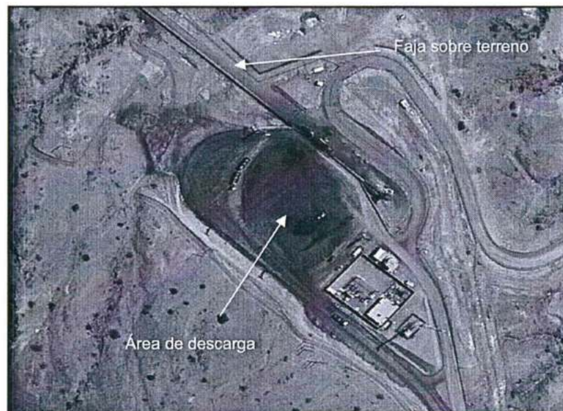
Imagen N° 1: Área de descarga y transporte mediante faja sobre terreno
