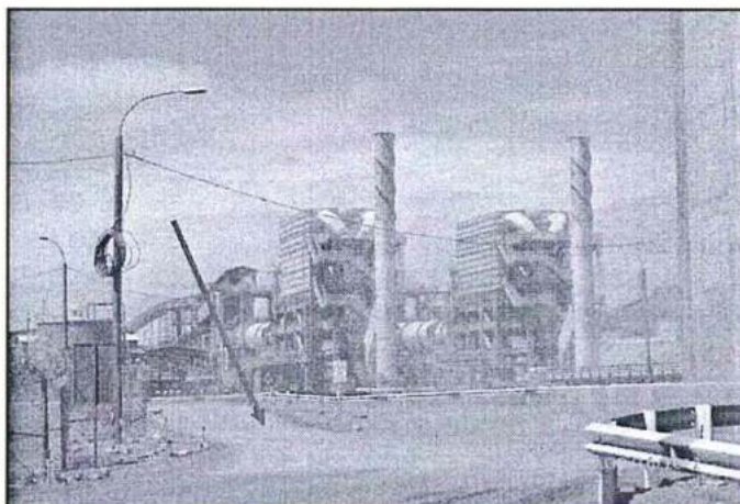
Fotografía N° 9 del Informe de Supervisión: Vía de acceso al área de secado y almacenamiento de concentrado de fosfatos, donde se produce levantamiento de polvo al paso de vehículos por falta de riego.
