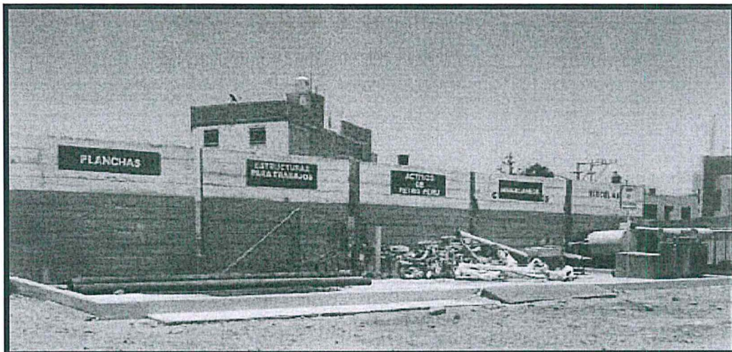
Fotografía 15. Zona de chatarra 1 17 .
