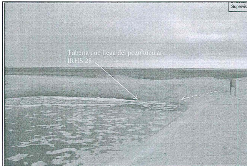
Fotografía N° 9 del Informe de Supervisión: Vista de la llegada de la tubería que se conecta al pozo IRSH a las pozas de evaporación, punto ubicado en las coordenadas UTM: 9373463 N, 537114 E.
