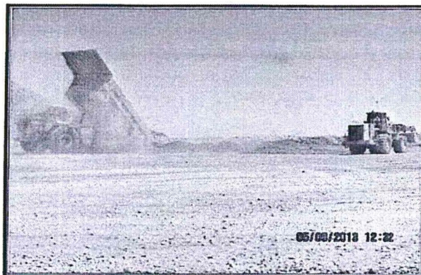
Fotografía N° 35: Hallazgo N° 3. Disposición de desmote en el Depósito de Desmote Torata Oeste. Se constató que en la disposición de desmote en el Depósito de Desmote Torata Oeste, no se regó las vías y plataforma de descarga del desmote, lo cual genera la emisión de material particulado.
