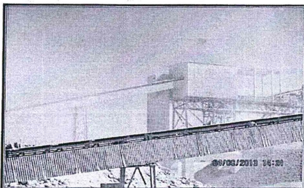
Fotografía N° 89: Medida de Mitigación N° 2. Mejoramiento del Programa de Supresión de Polvo en los Circuitos de Chancado y Aplamamiento. Se constató la emisión de material particulado, en el área de la faja transportadora y aplamamiento de mineral, cuando funciona el sistema de transporte de mineral chancado.
