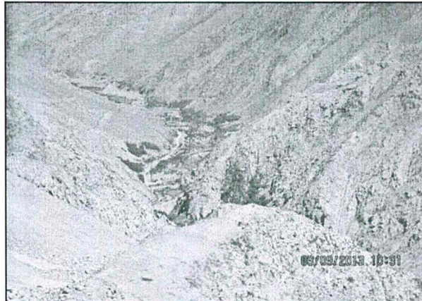
Hallazgo N° 12 de Gabinete: Zona de descarga del agua de las tuberías hacia el cauce natural de agua. No se observa la infraestructura para la colección de las infiltraciones de agua y estación de bombeo para su recirculación al proceso.
