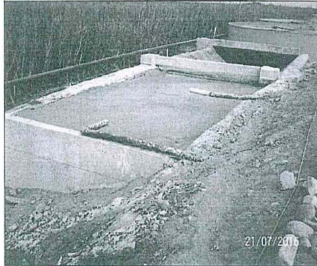
Imagen N° 03: Imagen del lecho de secado de lodos de la PTAR-I, concluido y operando.
