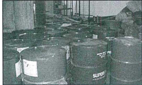
Fotografía N° 28: Cilindros con aceite dieléctrico usado (con sospecha de contenido de PCB), sin rotulado, contención de derrames y extintores contra incendio.
