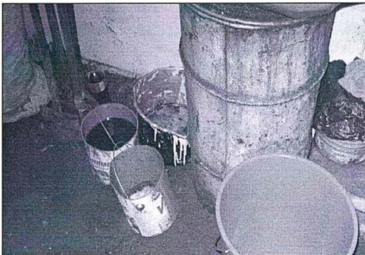
Fotografías N° 15 y 18: Cilindros con aceite usado, en CH Chamisería y CH Huarisca, almacenados inadecuadamente, respectivamente
