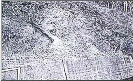
Fotografía N° 7: Pendiente erosionada con deslizamiento sobre la cámara de carga.
