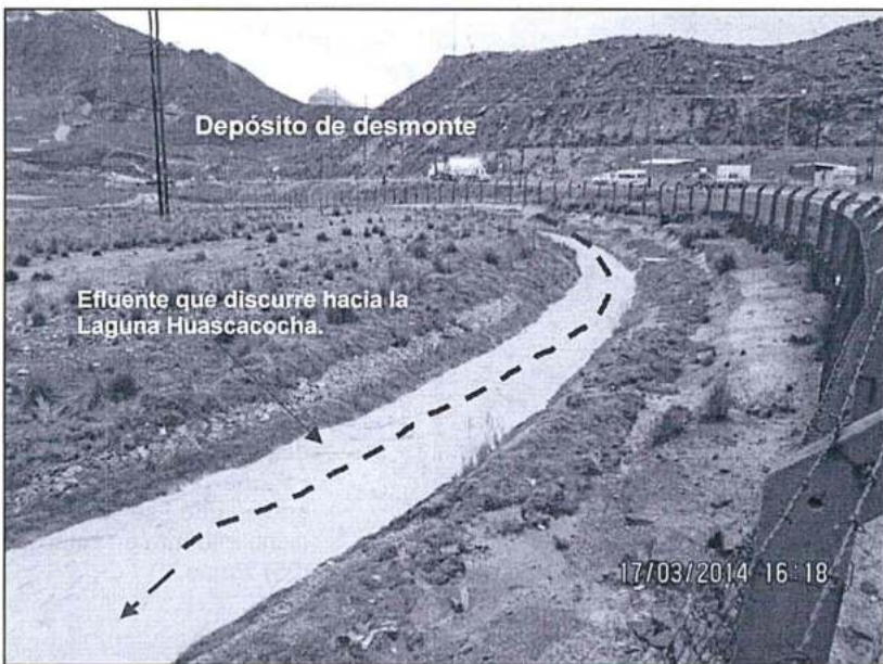
Fotografía N° 27: Canal de empedrado que colecta el efluente del depósito de desmonte oeste que descarga en la laguna Huascacocha.
