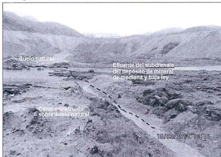
Fotografía N° 34: Efluente del subdrenaje del depósito de mineral de mediana y baja ley que discurre por un canal construido sobre suelo natural.
