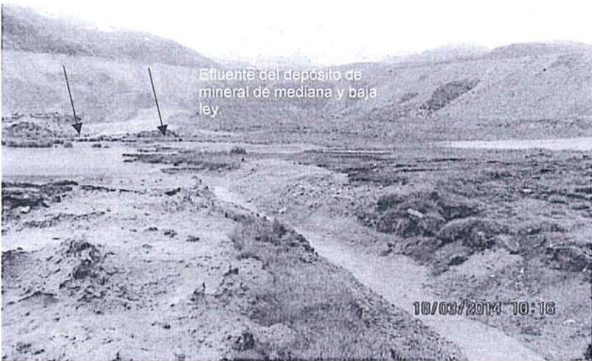
Fotografía N° 34. Efluente del subdrenaje del depósito de mineral de mediana y baja ley que discurre por un canal construido sobre suelo natural.
