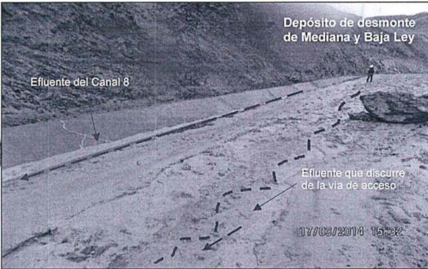
Fotografía N° 33. Efluente de la vía de acceso ubicado adyacente al canal 8.
