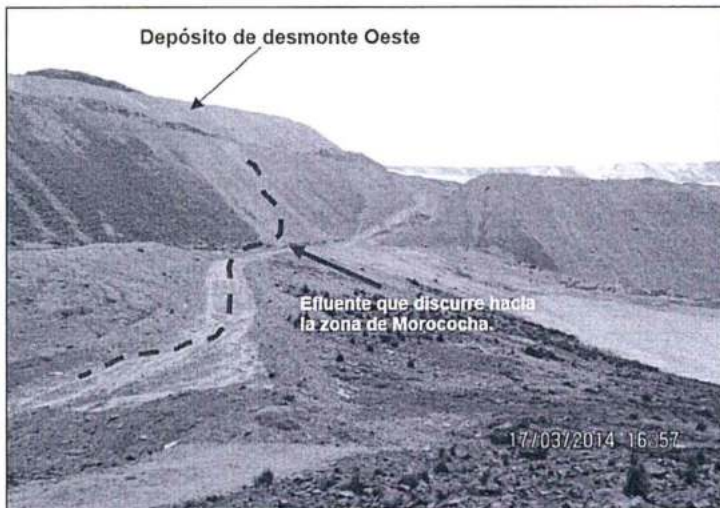
Fotografía N° 25: Efluente que discurre hacia la zona de Morococha, y luego es descargado a un canal de empedrado que descarga a la laguna Huascacocha.
