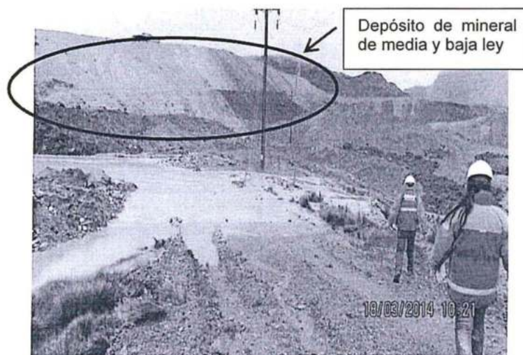
Fotografía N° 36: Efluente del subdrenaje del depósito de mineral de mediana y baja ley, se juntan con sedimentos provenientes del talud de la vía de acceso para ser
