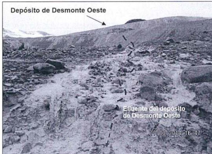
Fotografía N° 4: Efluente del depósito de desmontes que discurre por suelo natural del talud adyacente al depósito de desmonte.
