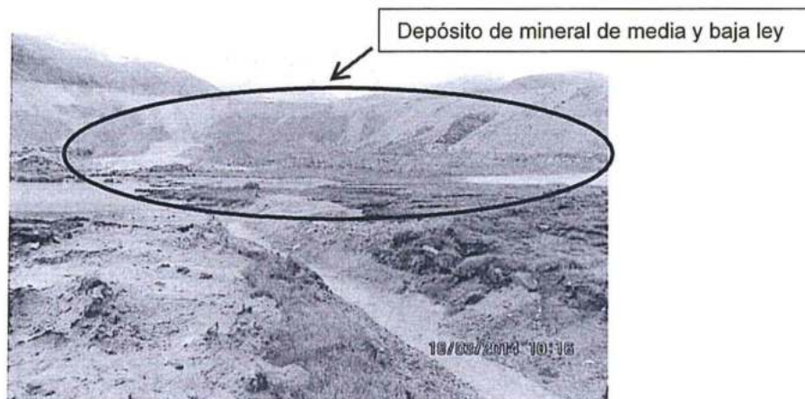
Fotografía N° 34: Efluente del subdrenaje del depósito de mineral de mediana y baja ley que discurre por un canal construido sobre suelo natural.
