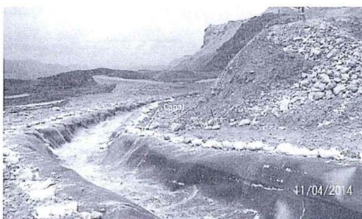
Fotografía N° 5 Vista del canal revestido con geomembrana que conecta la poza 4 A y 4 B, ubicado en la parte baja del depósito de desmontes Oeste. Ubicado en las coordenadas 8716807N, 373894E – WGS84.
