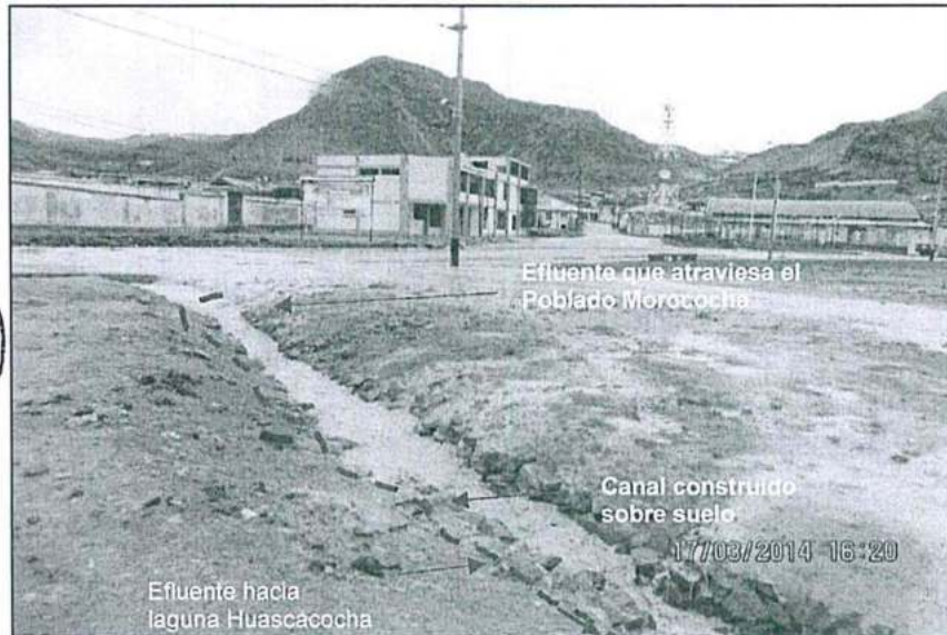
Fotografía N° 45. Descarga del canal 8 que discurre sobre suelo natural y canal construido sobre suelo natural después del acceso del poblado de Morococha.
