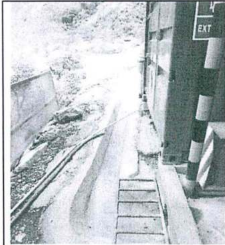
Foto 1 - Cuneta perimetral de la zona de mantenimiento en Ventana 1
