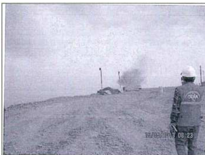
Fotografía N° 134: Emisión de material particulado al ambiente durante el nivelado de la zona de descarga de escorias.
