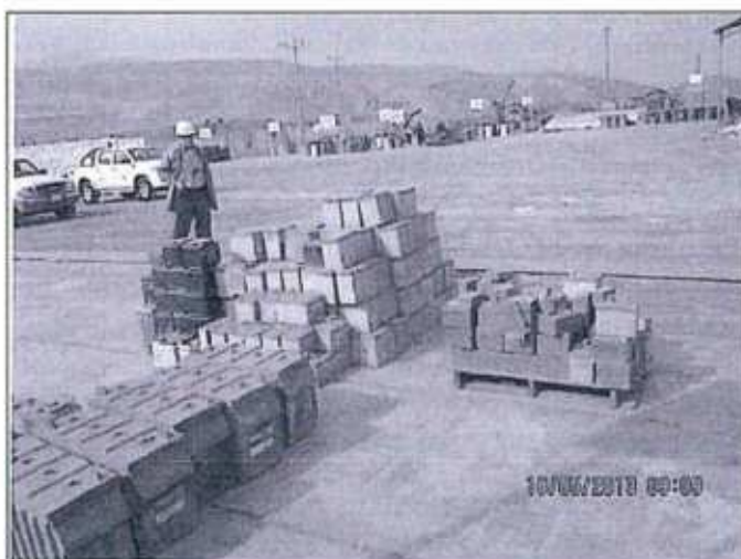
Fotografía N° 228: Almacenamiento de baterías en terreno abierto y no están dentro de un contenedor.
