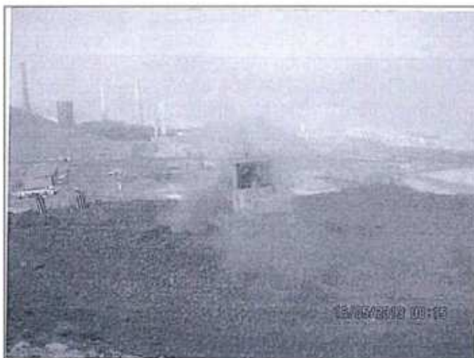
Fotografía N° 133: Nivelado de la zona de descarga de escorias, observase la emisión de material particulado al ambiente.
