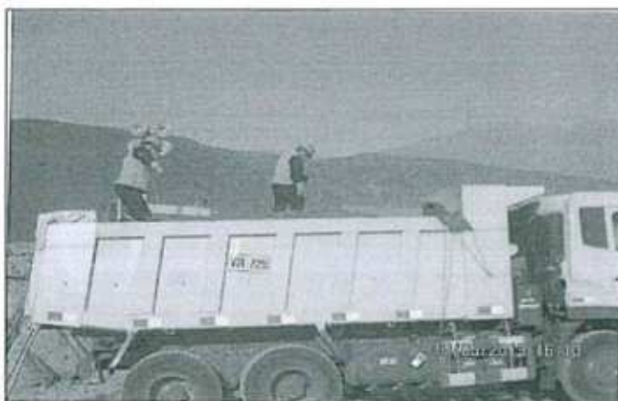
Fotografía N° 139: Carga de escorias a volquete de Consorcio Virgen de Chapi Ilo – Perú.
