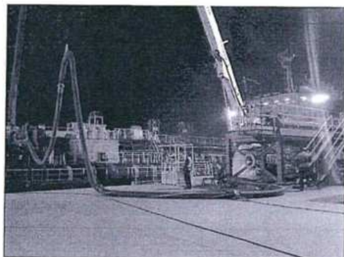
Fotografía N° 166: Embarque de ácido sulfúrico. No se observa el recipiente de PVC para atrapar los posibles goteos.
