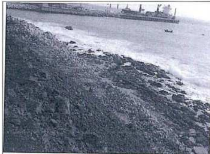
Fotografía N° 144: Escorias almacenadas en el terminal portuario de Empresa Nacional de Puertos. El pie de talud se encuentra próximo al mar.
