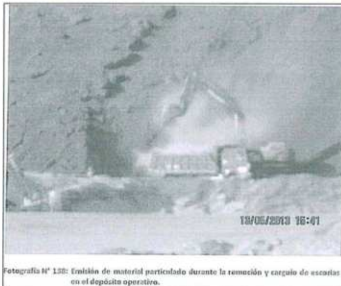
Fotografía N° 129: Emisión de material particulado durante la remoción y carguío de escorias en el depósito operativo.
