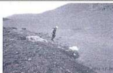
Fotografía durante la Supervisión Regular
