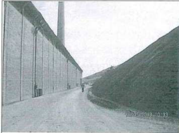
Fotografía N° 150: En la parte superior del muro se ha instalado malla cortaviento para minimizar los efectos de la acción del viento en la runa de concentrados.
