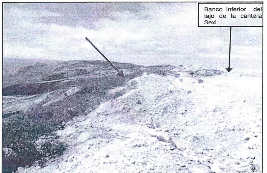
Foto N° 09: Vista del perímetro del tajo de la Cantera Sexi, no se observa canal de coronación para conducción de escorrentías.
