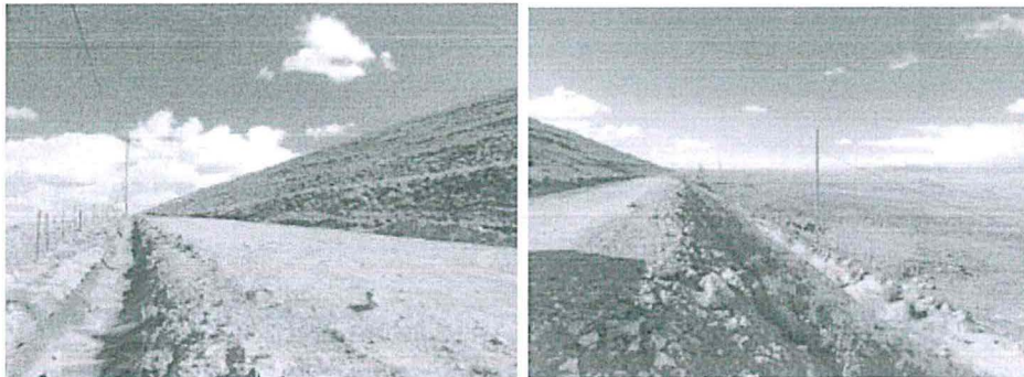
Fotografías 9 y 10 24 : Lado Este del canal Coordenadas UTM N: 8 817 255 y E 349 259 (izquierdo) y N 8 816 830 y E 349 107 (derecho)
