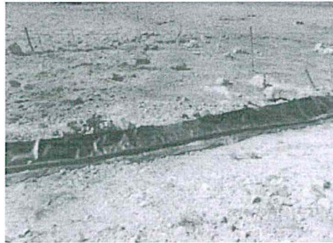
Fotografía 8 23 : Lado Norte del canal Coordenadas UTM Coordinadas N: 8 817 374 y Este 349 014
