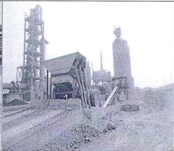
Foto 10.- Vía de acceso al costado derecho de la línea de molienda de crudos, se evidencia falta de afirmado de la misma. Coordenadas UTM WGS 84 E 293192 N 8673827.
