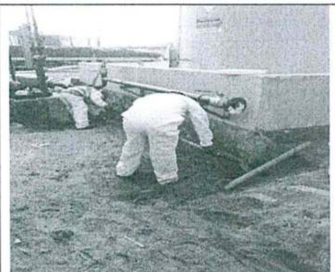
Foto N° 3: Retiro de suelo previo a construcción de losa.
