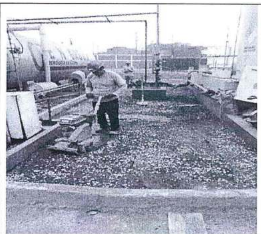
Foto N° 5: Construcción de perímetro y losa.
