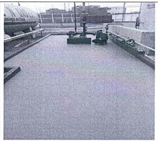
Foto N° 7: Trabajos terminados de revestimiento de losa con poliuretano.
