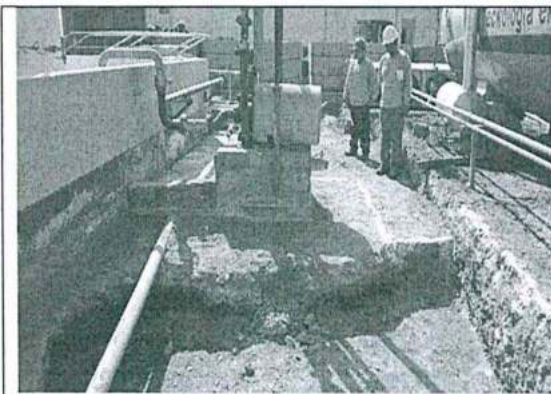
Foto N° 2: Demarcación de zona sobre la cual implementar losa.
