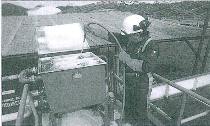
Fotografía N° 7: Limpieza de los bordes interiores de la PTARD
