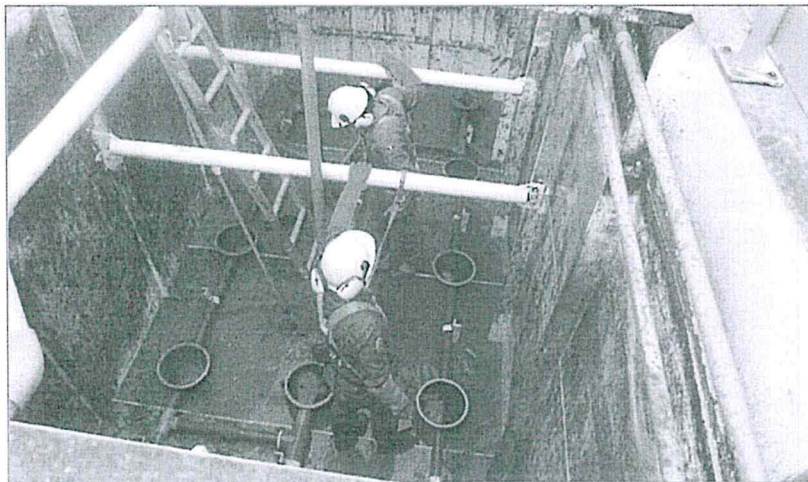
Fotografía N° 8: Retiro de lodos del tanque equalizador y aeróbico
