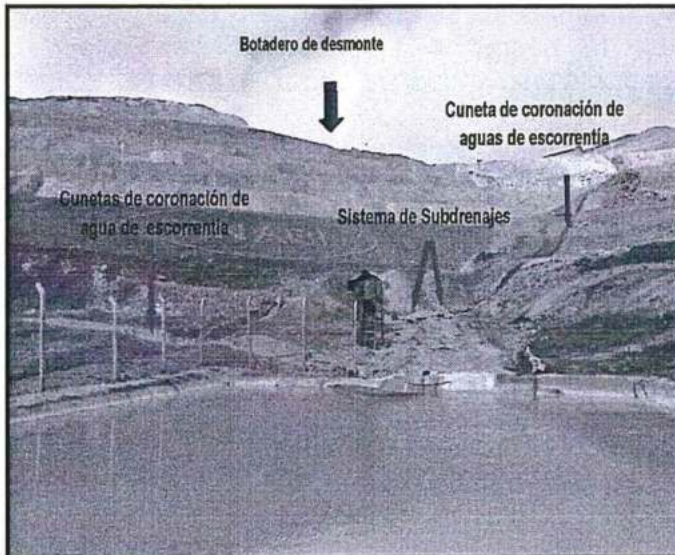
Fotografía N° 10. Se observa una poza de colección, donde se almacenan las aguas provenientes de los canales de derivación de aguas de escorrentía y del sistema de subdrenaje, del Botadero de desmote.
