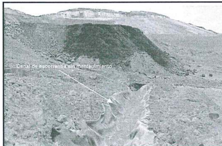
Fotografía N° 25: En el sector Yanama donde se encuentra el depósito de desmonte los canales de escorrentías se encuentran sin mantenimiento. No se encuentran bien perfilados y definidos, hay presencia de rocas, sedimentos e ichi de los mismos.
