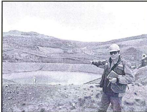
Fotografía N° 57.- Cumplimiento de la recomendación 3: Vista de poza de grandes eventos a un 15% de su capacidad aproximadamente, habilitada para casos de contingencias.
