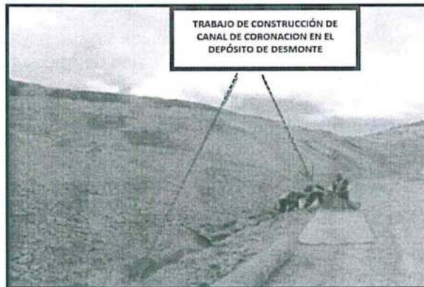
Foto N° 4. Implementación del canal de coronación del depósito de desmonte.
