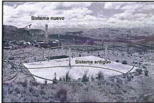
Fotografía N° 18. Vista del antiguo y nuevo sistema de tratamiento de las aguas residuales domésticas instalado por Anabi SAC en el presente año.
