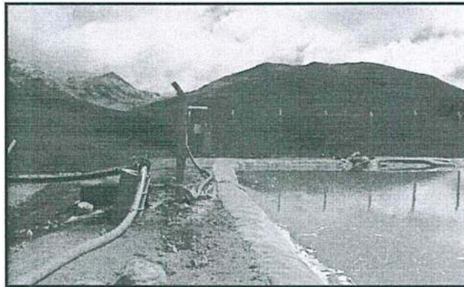
Fotografía N° 14. Vista del sistema de tuberías que transporta agua almacenada en la poza de colección del botadero desmonte. parte se dirige hacia la zona de procesamiento y la otra es utilizada para el riego de los caminos de acceso con que cuenta el proyecto en su interior.
